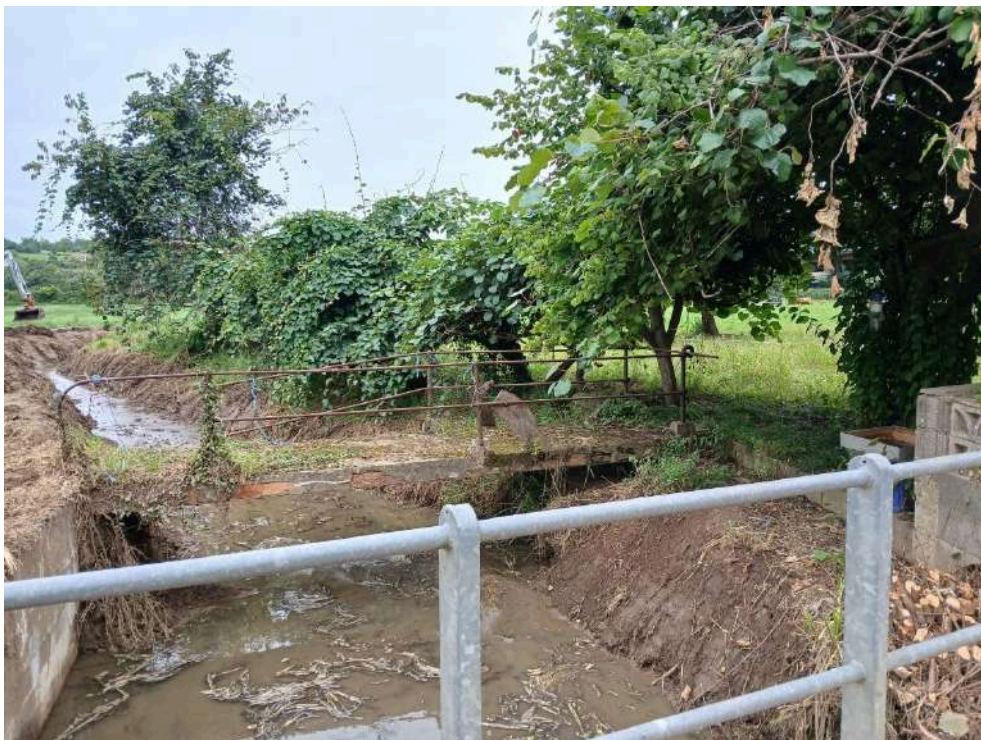
Después de los trabajos
