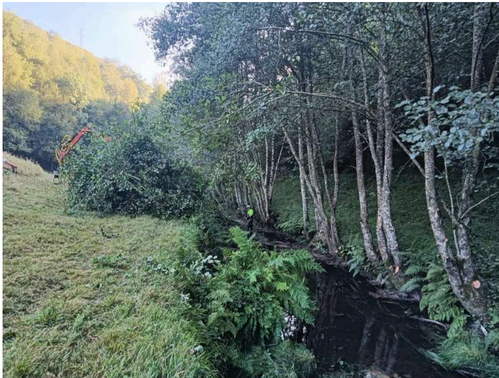
Operario y autocargador retirando restos vegetales
