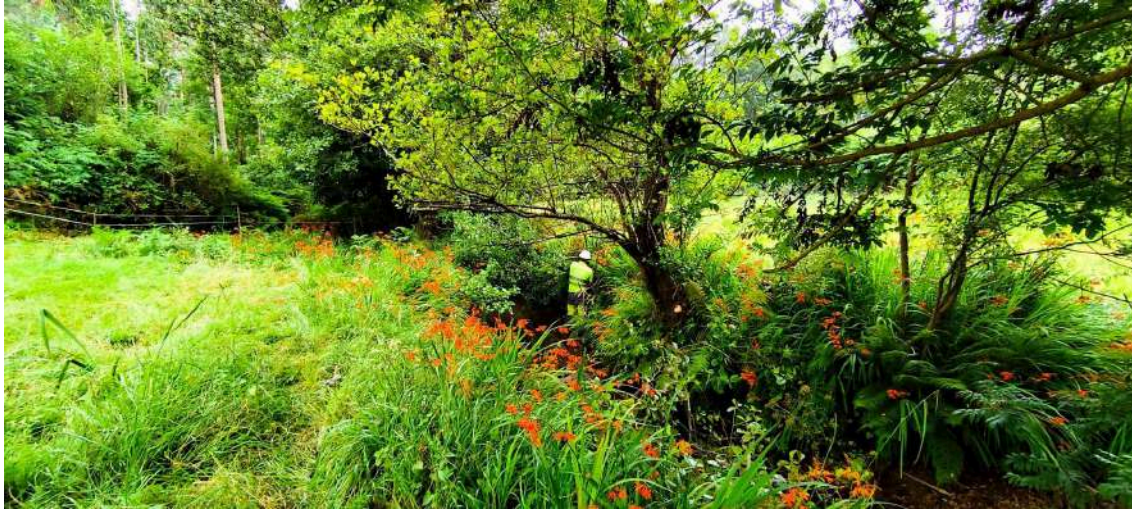
Operarios retirando desbrozando vegetación dentro del cauce
