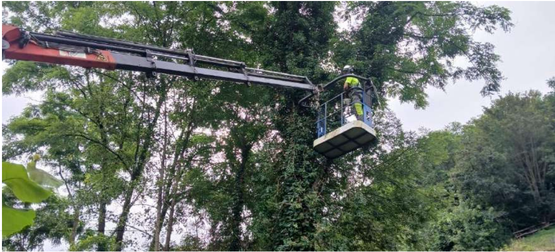
Autogridador retirando restos vegetales del cauce
