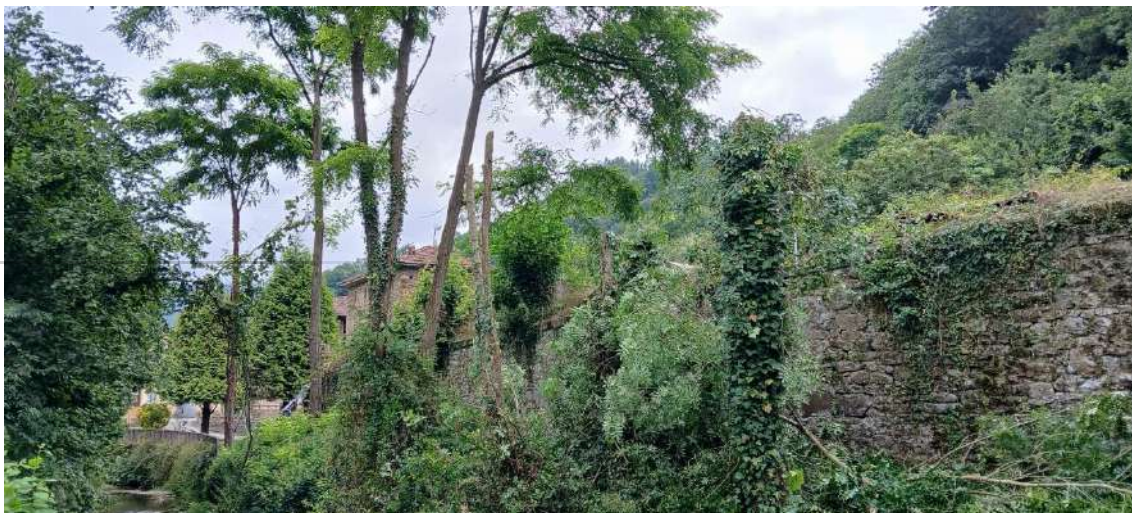
Después de los trabajos
