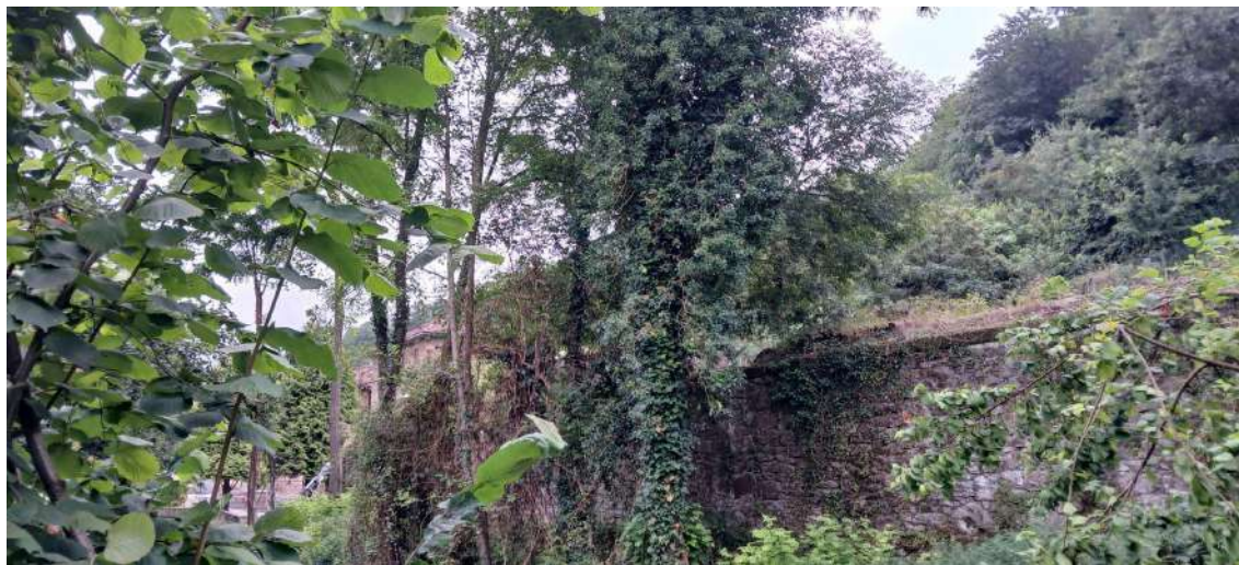
Antes de los trabajos
