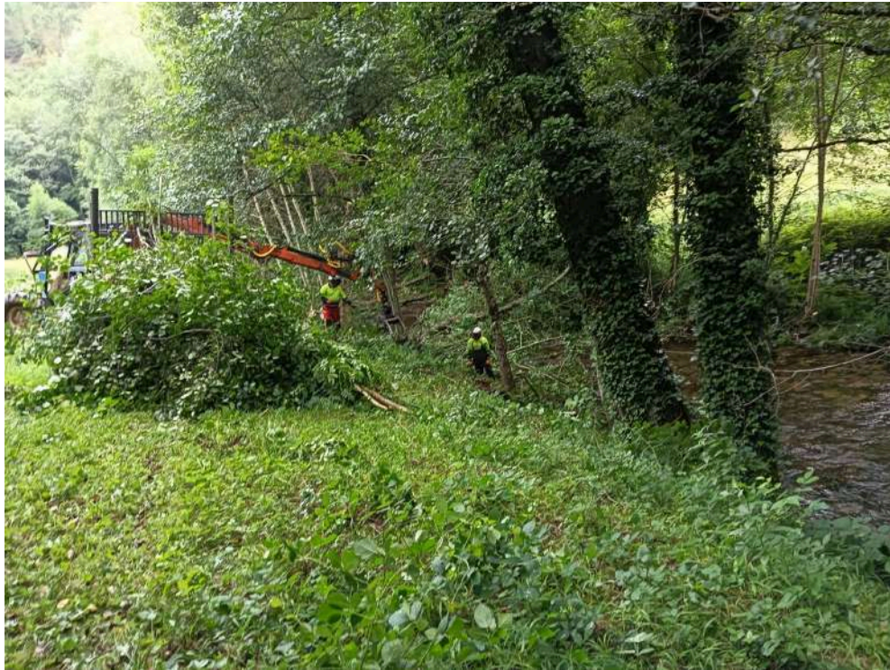
Operarios y autocargador retirando restos vegetales
