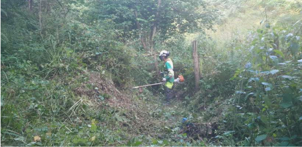
Durante los trabajos. Operario desbrozando vegetación dentro del cauce
