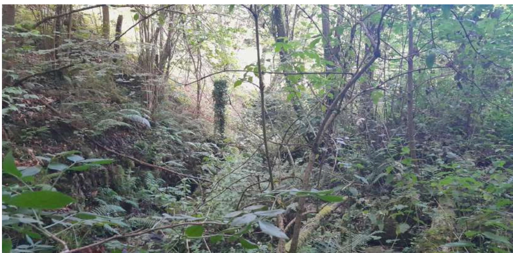
Antes de los trabajos. Cauce tomado por la vegetación
