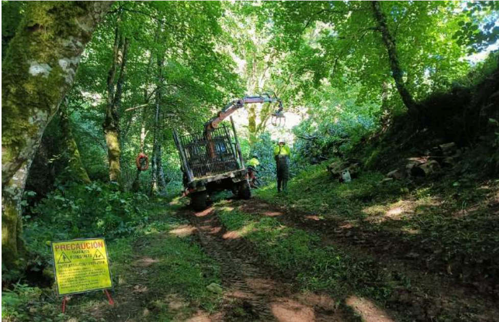
Operarios y autocargador retirando restos vegetales
