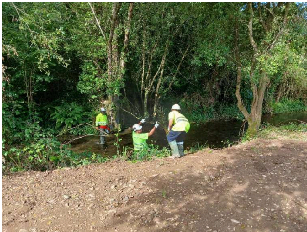
Operarios retirando restos vegetales del cauce
