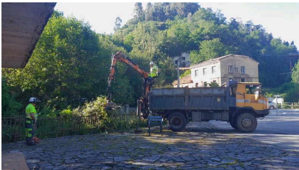
Durante los trabajos. Operarios y camión tipo URO retirando restos vegetales
