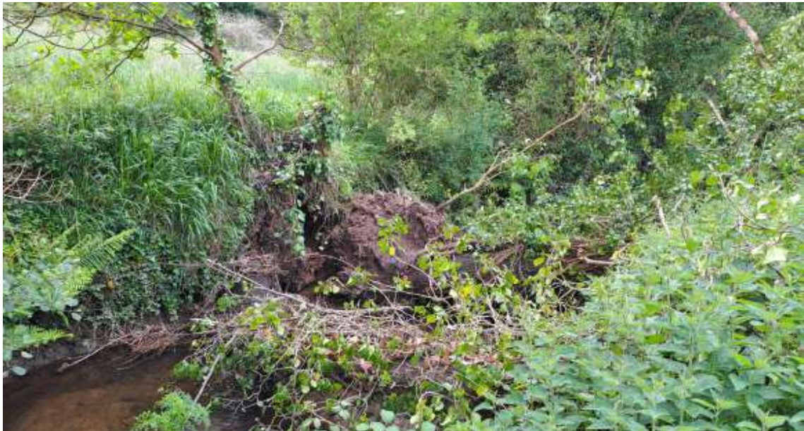
Antes de los trabajos en el río de Anguleira. Árbol caído y vegetación creciendo dentro del cauce
