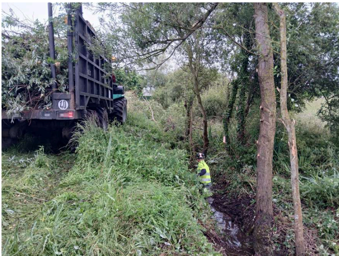
Operario y autocargador retirando restos vegetales del cauce del río Tapia
