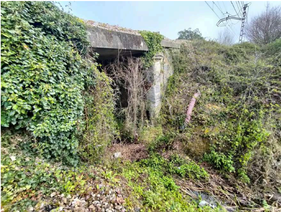
Antes de los trabajos
