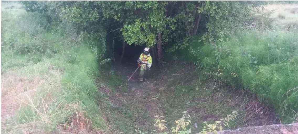
Operario desbrozando dentro del cauce
