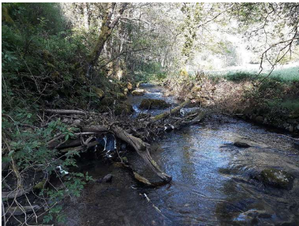
Antes de los trabajos
