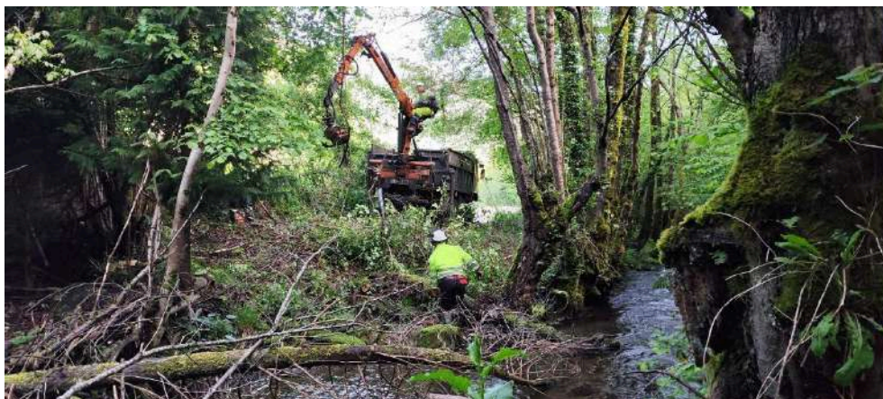
Inicio de los trabajos, operario y Uro retirando restos vegetales
