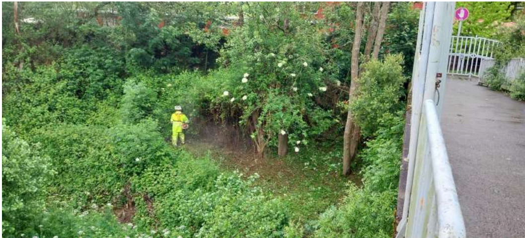
Inicio de los trabajos
