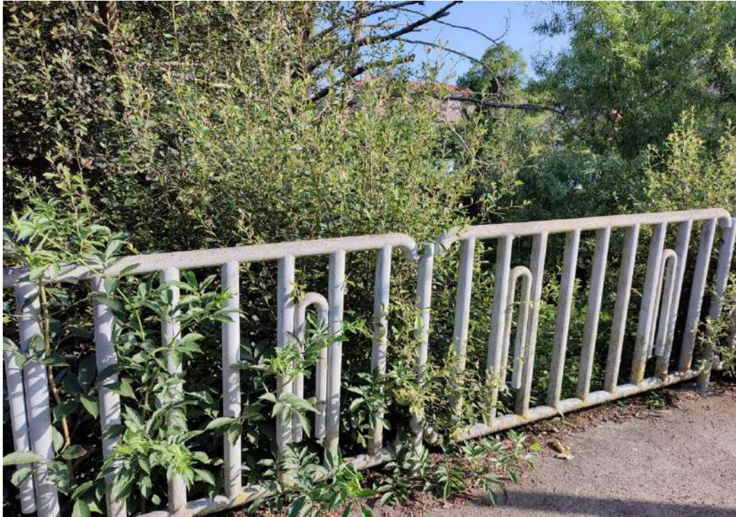
Antes de los trabajos
