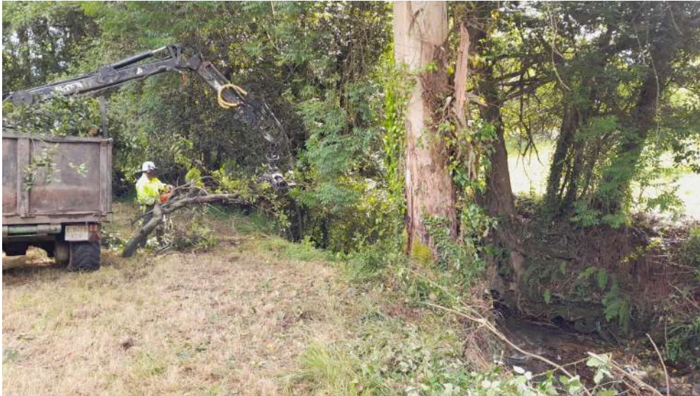
Operarios y autocargador retirando restos vegetales
