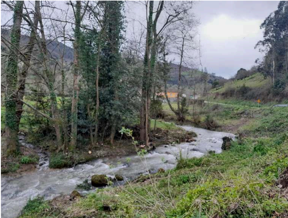
Después de los trabajos
