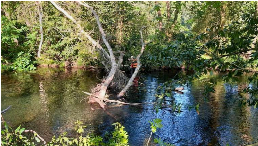
Operario colocando cable alrededor de árbol para sacarlo con el cabrestante del autocargador
