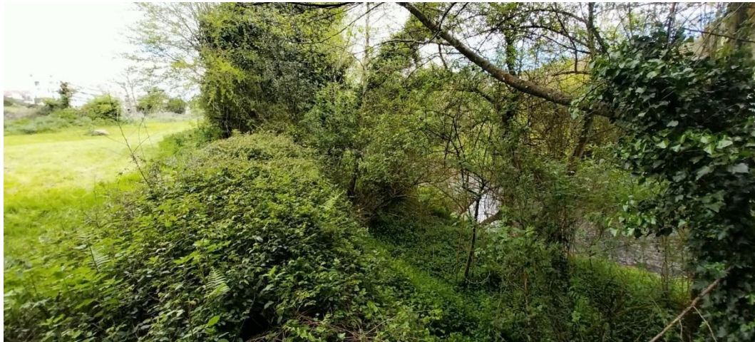
Cauce tomado por la vegetación antes de los trabajos
