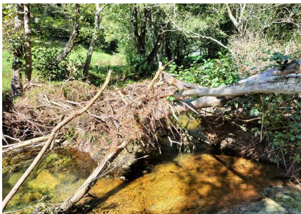
Tapón vegetal antes de los trabajos
