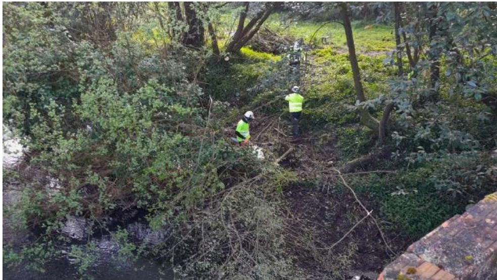
Operarios retirando restos vegetales del cauce del Meiro
