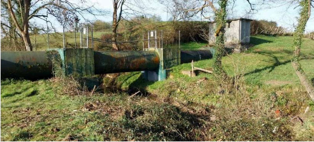
Después de los trabajos
