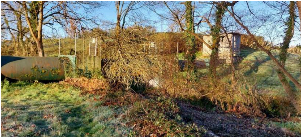
Antes de los trabajos
