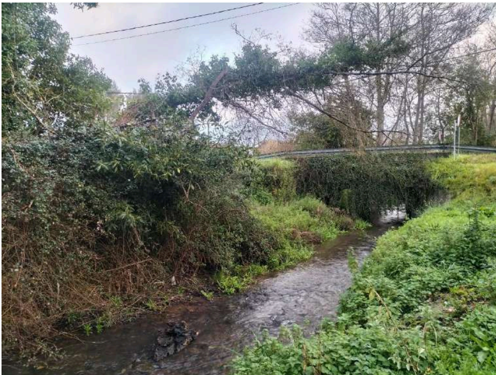
Antes de los trabajos
