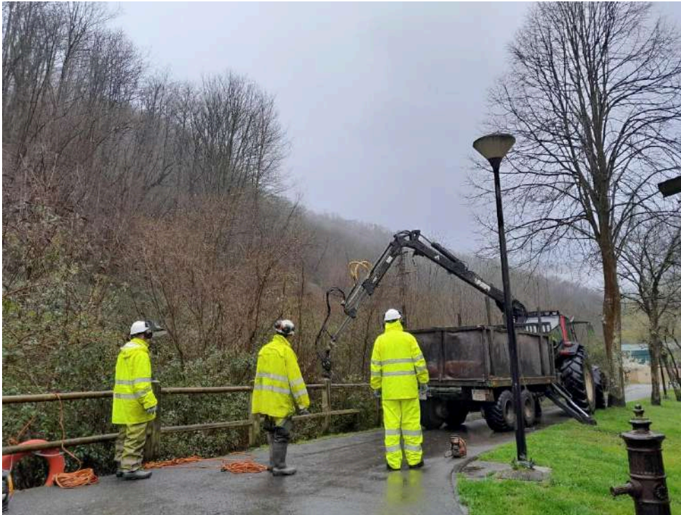
Autocargador retirando restos vegetales del cauce
