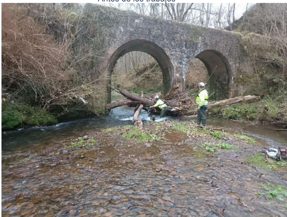
Operarios retirando restos vegetales del cauce
