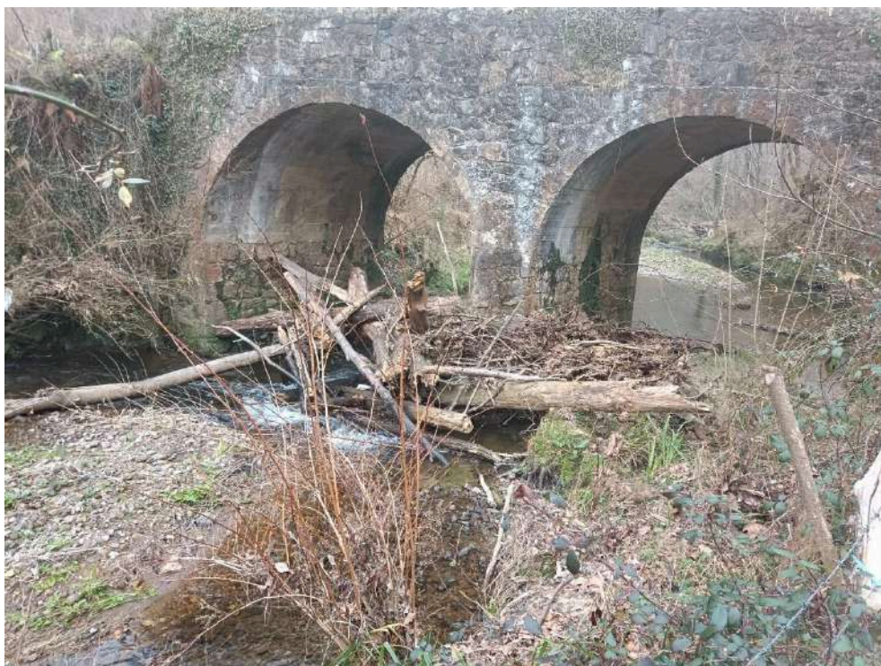
Antes de los trabajos
