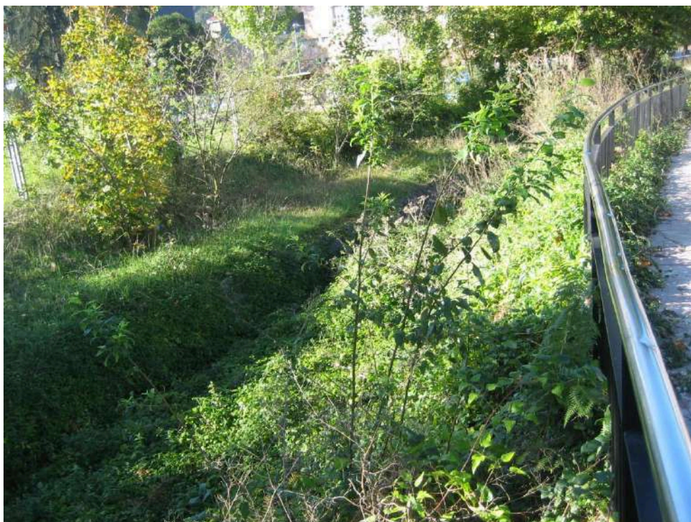
Antes de los trabajos
