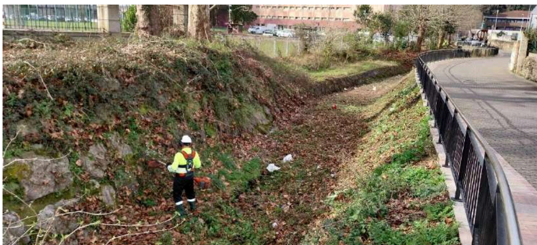
Operario desbrozando vegetación dentro del cauce
