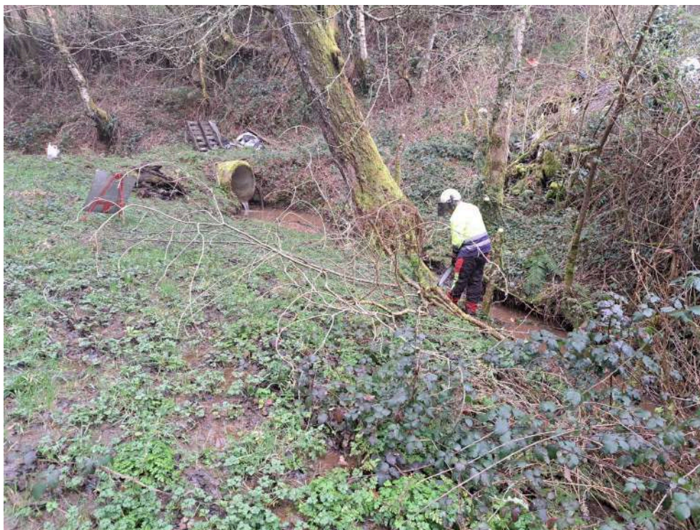
Operario retirando restos vegetales
