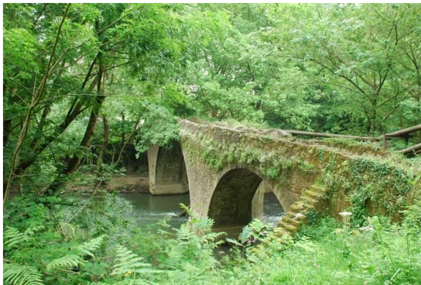
Figura 207.- Puente de Torrezabal
