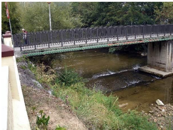
Figura 114.- Pasarela de acceso a instalaciones deportivas
