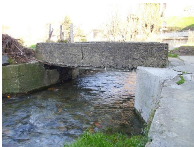
Figura 223.- Paso sobre el río Goiztarán
