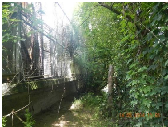
Figura 132.- Zona del acondicionamiento del río Ibaizabal
