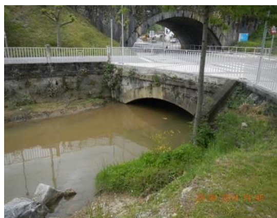
Figura 107.- Salida de la cobertura del río Asteasu
