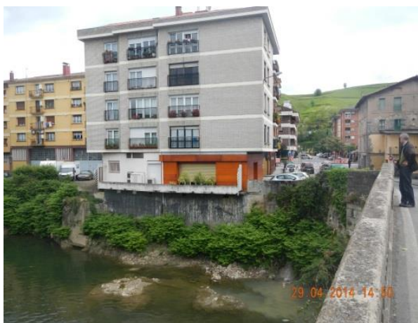
Figura 103.- Vista de la MD del Oria justo a/abajo del puente de Zubimusu donde se propone el muro de defensa
