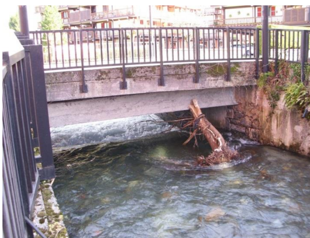
Figura 212.- Puente en la calle Antoiu
