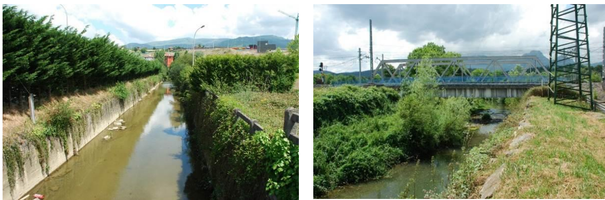
Figura 138.- Río Sarría. Tramo canalizado a su paso por el polígono industrial Traña Matiena. A la dcha. comienzo del tramo del tramo encauzado a la altura del puente del ferrocarril
