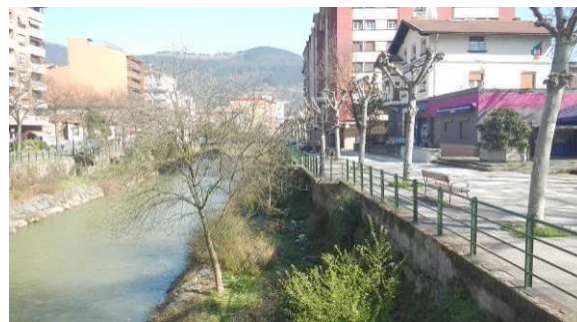
Figura 172.- Vista de bermas intermedias en ambas márgenes a la altura del puente de Zubiko
