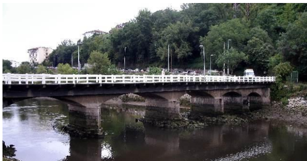
Figura 7.- Puente de Egia
