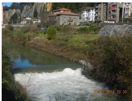
Figura 176.- Azud en Arteta con carga de sedimentos en su trasdós.
