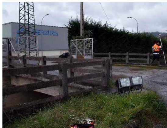
Figura 130.- Paso a sustituir en zona industrial
