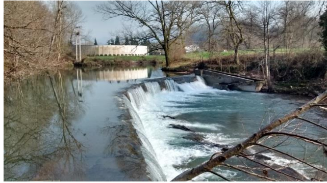
Figura 229.- EDAR de Baztán desde el azud de aguas abajo
