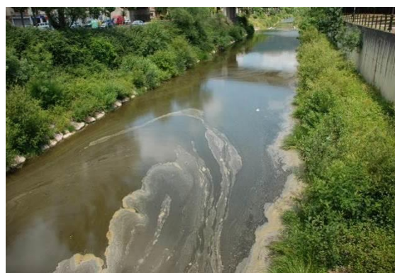
Figura 189.- Nervión la altura de Goikoetxe. Detalle de las aguas. Se observa la banqueta de aguas bajas y la escollera y muro de contención junto al paseo de la margen derecha.
