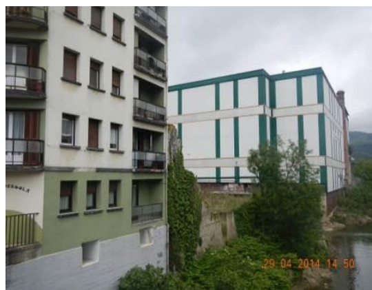
Figura 106.- Edificio en MI del río Oria justo a/abajo del puente de Zubimusu
