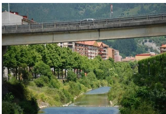
Figura 189.- Nervión la altura de Goikoetxe. Detalle de las aguas. Se observa la banqueta de aguas bajas y la escollera y muro de contención junto al paseo de la margen derecha.
