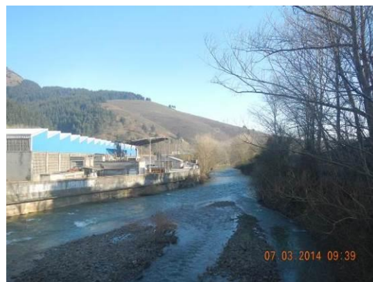
Figura 177.- Imagen aguas abajo del puente de Isla de Ugarriza con las instalaciones de PH Norten a la izquierda.
