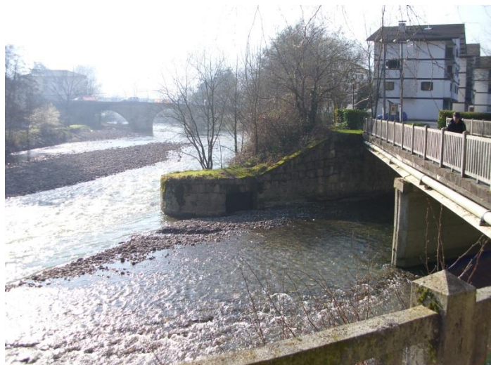
Figura 217.- Puentes sobre el río Ezcurra y Bidasoa en la confluencia de ambos
