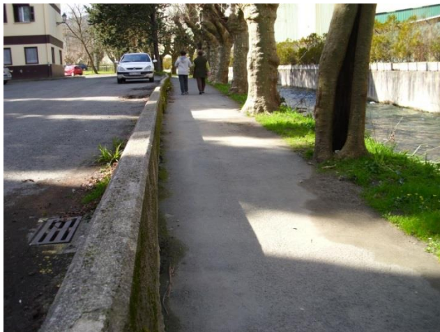
Figura 213.- Paseo peatonal en margen derecha del río Onín
