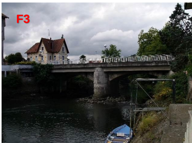
Figura 21.- Puente actual de Martutene
