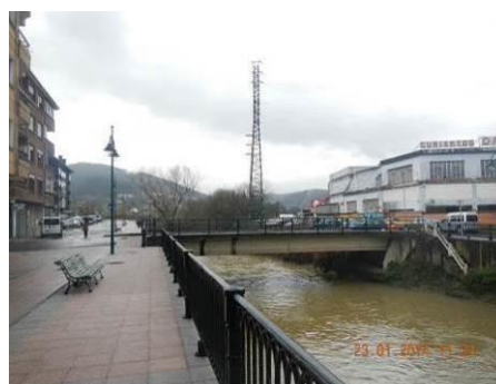
Figura 81.- Puente de Rentería
