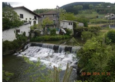
Figura 62.- Azud a demoler
