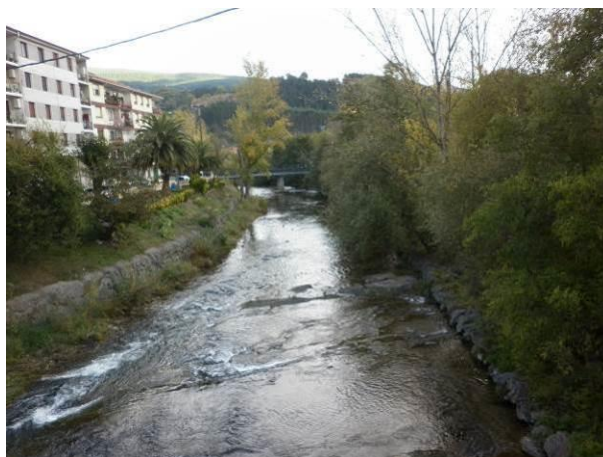
Figura 124.- Vista hacia aguas abajo desde el puente de El Charco. Se puede ver la diferencia en la vegetación de ambas márgenes
