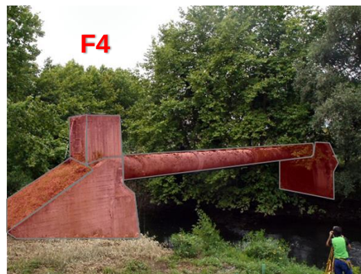
Figura 22.- Estructura a demoler de Aguas de Añarbe
