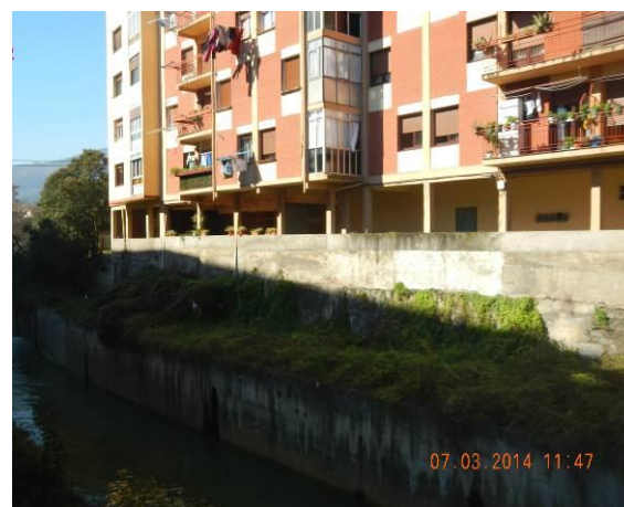
Figura 170.- Edificio de la calle Doctor Fleming
