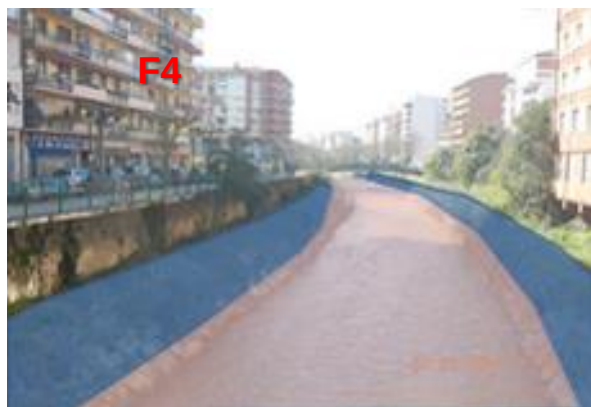
Figura 184.- Regularización, ampliación del cauce de aguas bajas y acondicionamiento de márgenes junto al puente de La Estación
