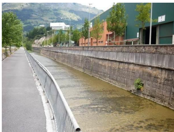
Figura 60.- Tramo central del río
