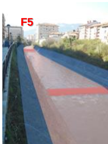
Figura 186.- Demolición del azud previa confluencia del Inarrondo y azudes de escalonamiento para permitir la regularización del fondo y la ampliación del cauce
