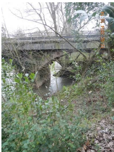
Figura 196.- Recalce de las pilas del Puente de Plazakoetxe
