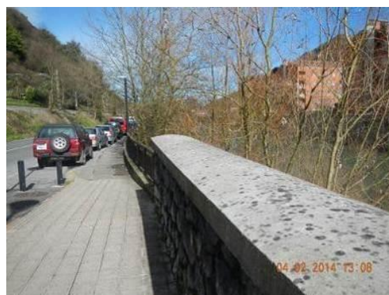
Figura 146.- Fin de muro existente y zona a ejecutar muro
