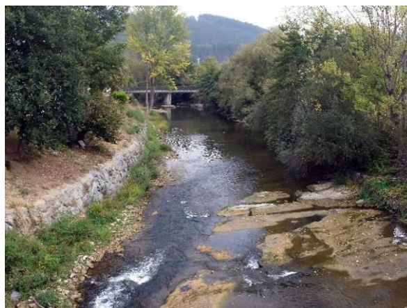
Figura 118.- Zona de inicio de la corta (margen derecha) entre puente del El Charco y pasarela (al fondo de la fotografía)
