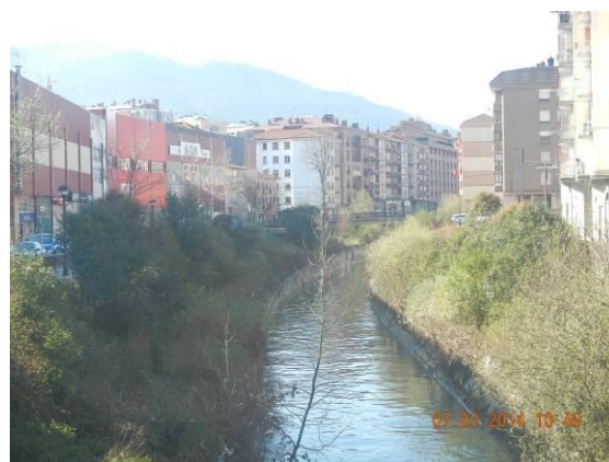
Figura 168.- Cauce de aguas bajas y encauzamiento del principal visto desde el puente de Altzarrate hacia aguas arriba
