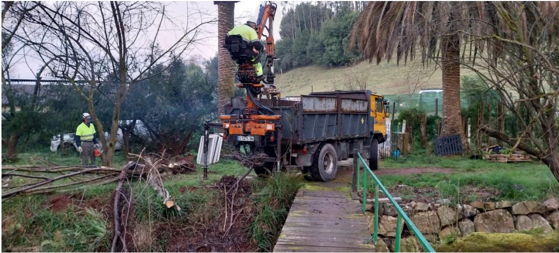
Operarios y camión tipo URO durante los trabajos
