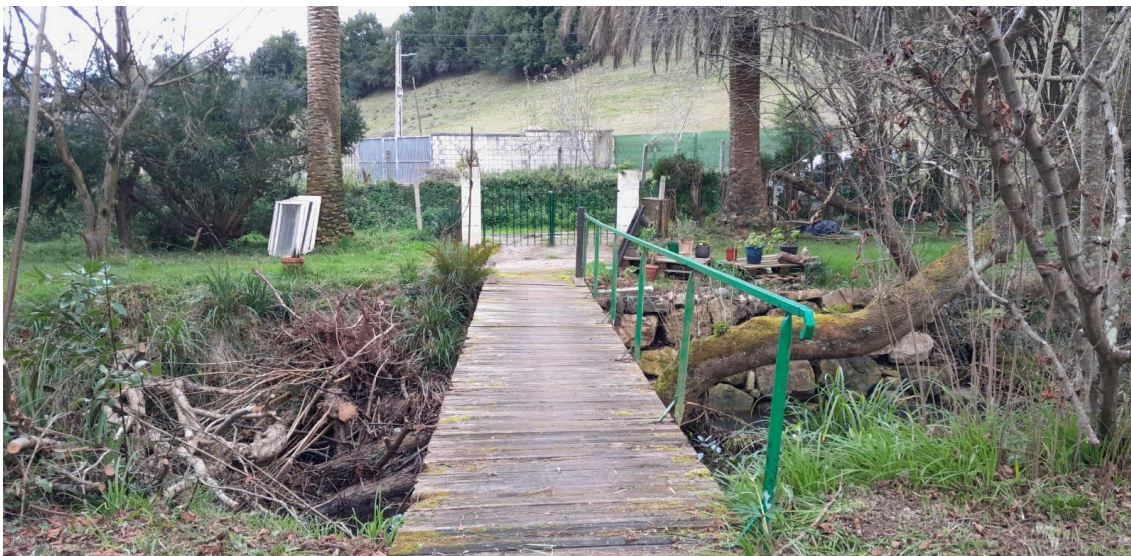
Antes de los trabajos
