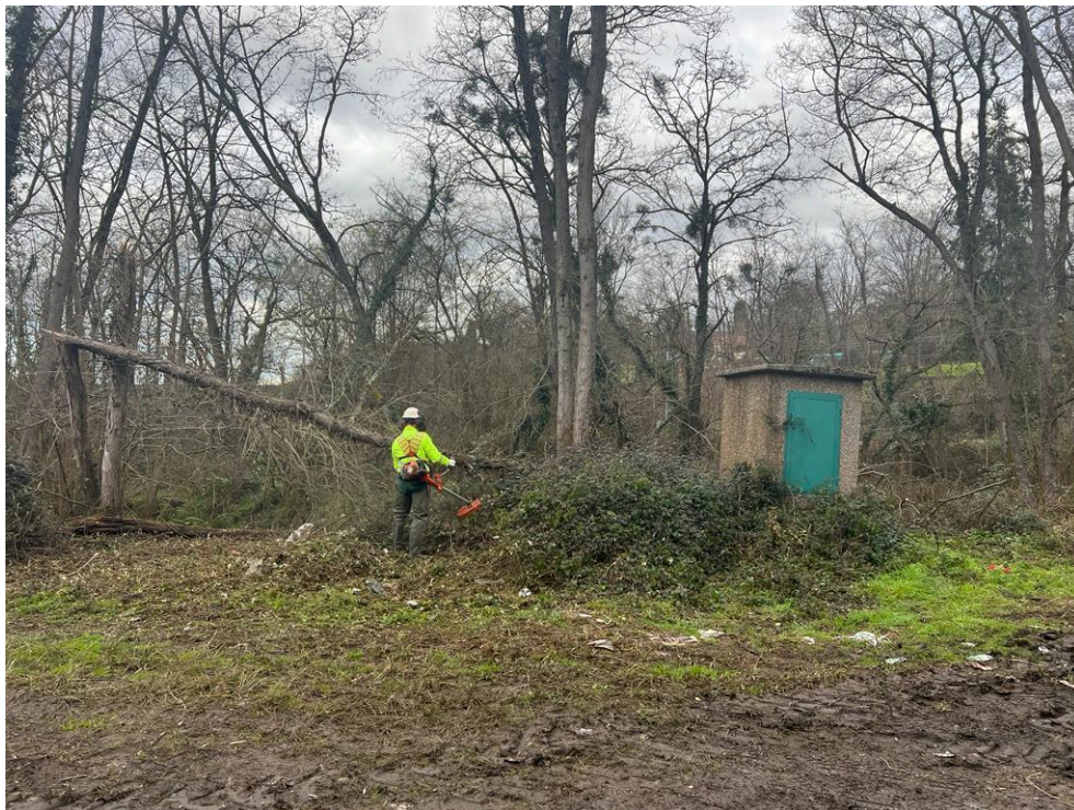
Operarios desbrozando vegetación
