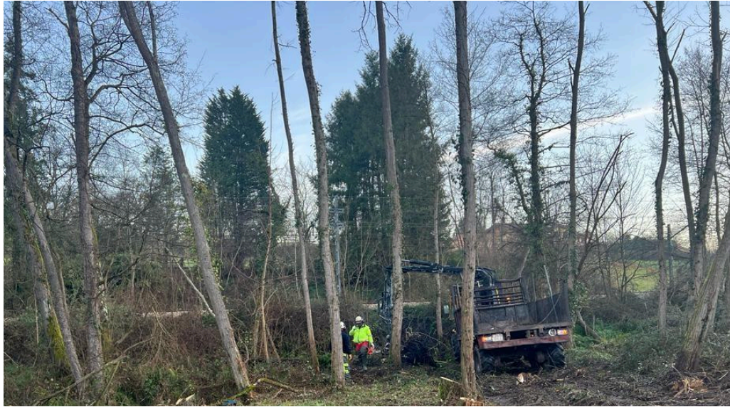
Operarios desbrozando vegetación
