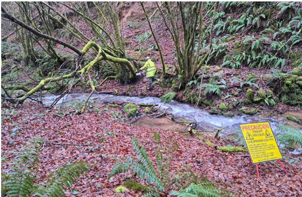
Trabajos sobre la vegetación del cauce
