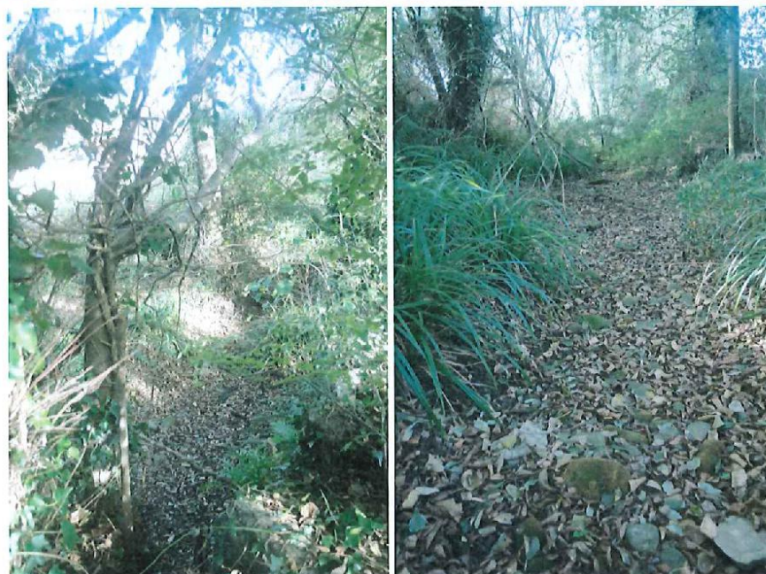
Lecho del encauzamiento del aliviadero
