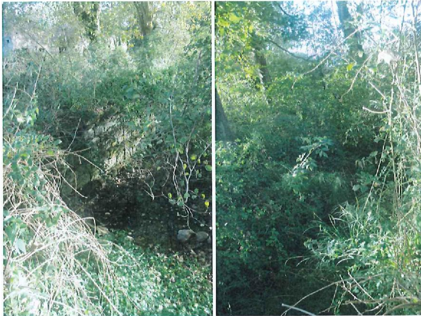
Encauzamiento del aliviadero
