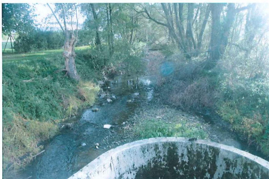
Río Parayas-Suscuaña aguas arriba, vaso de la presa
