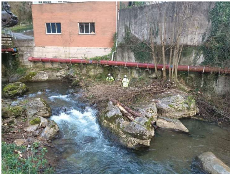
Retirada de restos vegetales acumulados en el cauce
