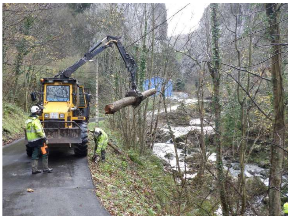
Trabajos de extracción de árboles caídos
