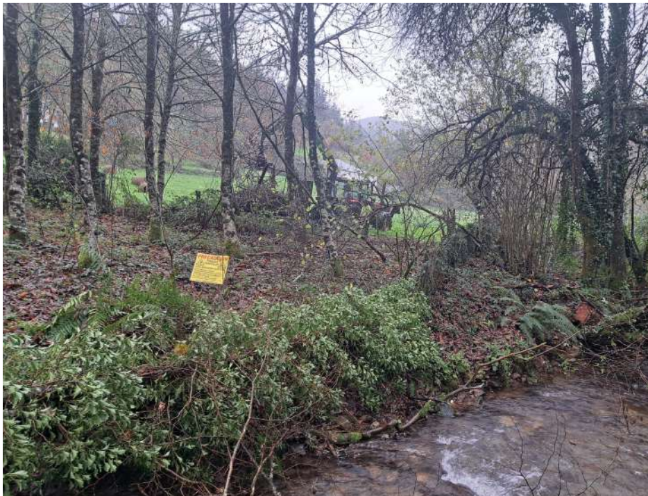
Zona de actuación durante los trabajos
