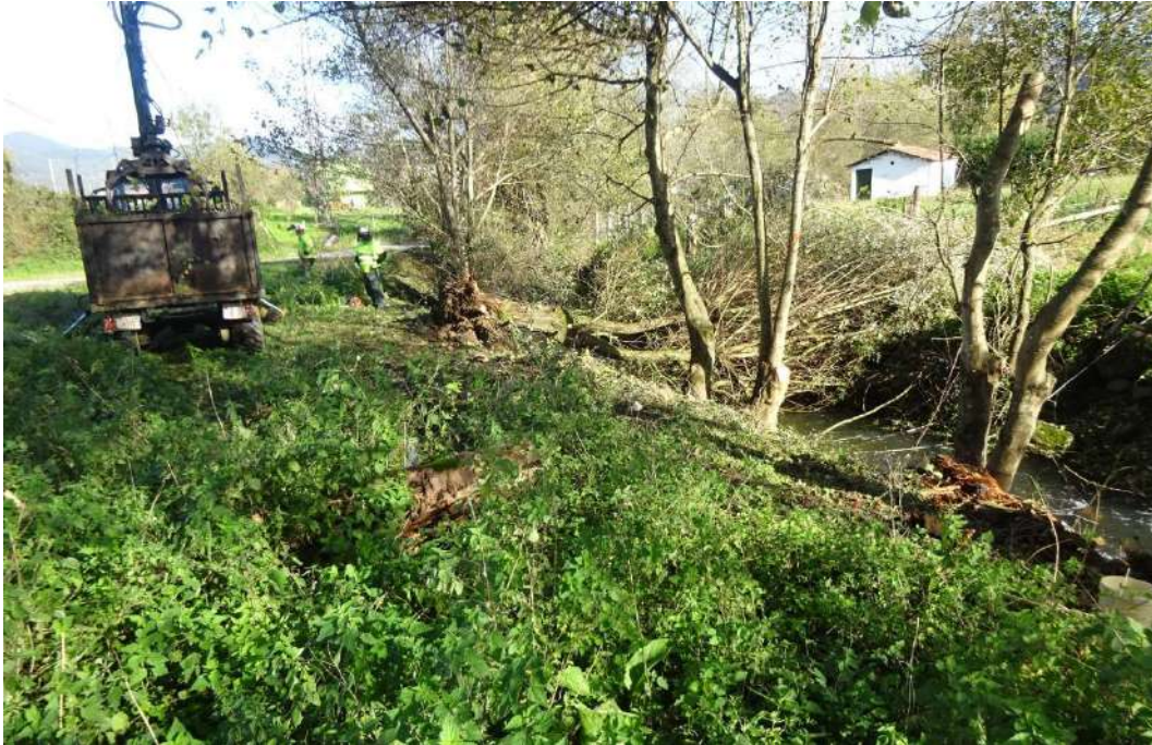
Retirada de árboles caídos
