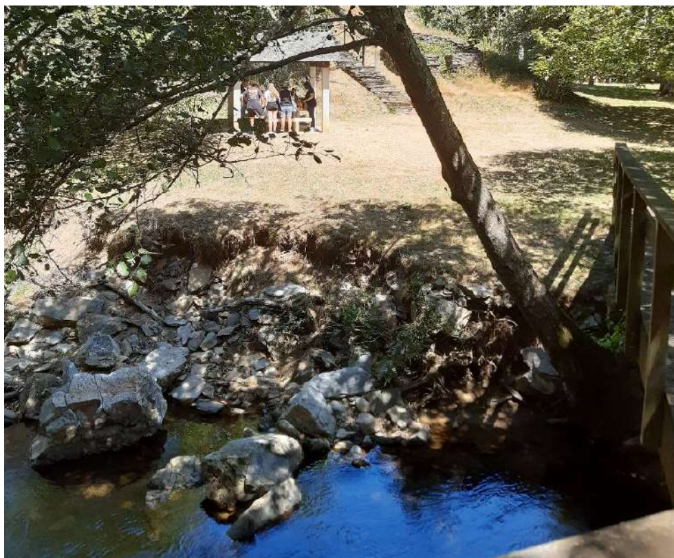
Antes de los trabajos
