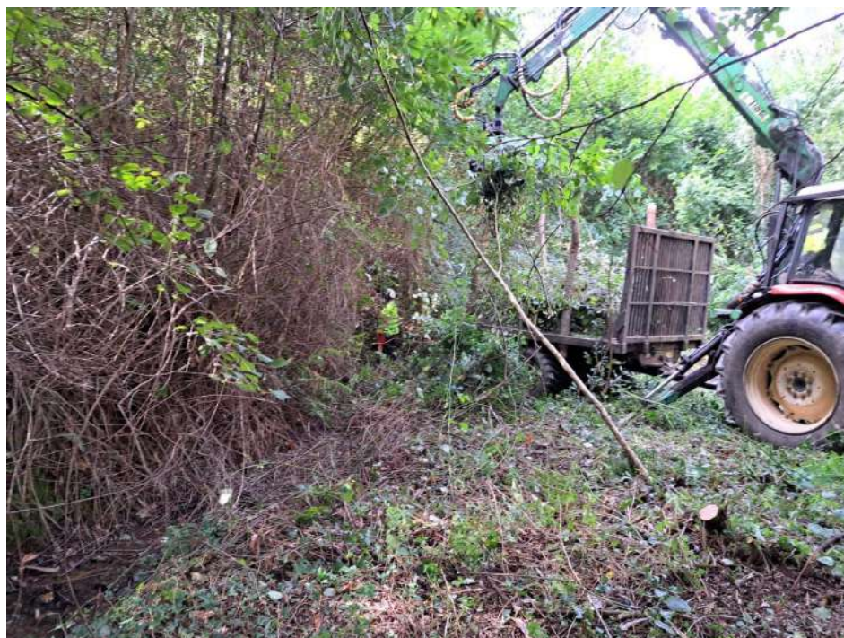
Retirada de restos vegetales de la margen
