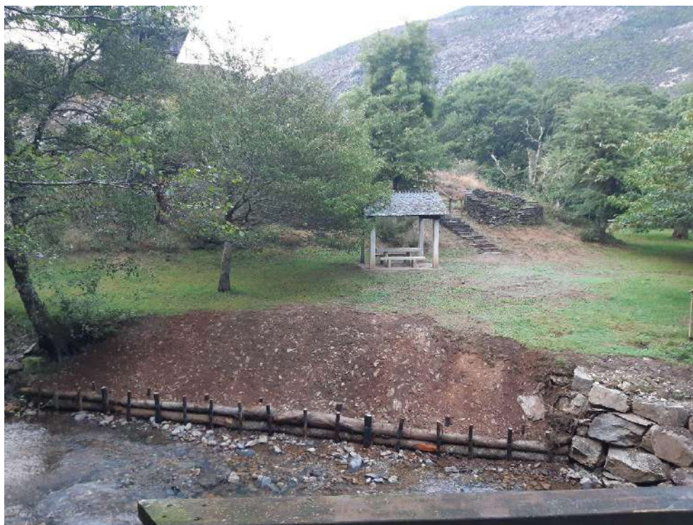
Después de los trabajos
