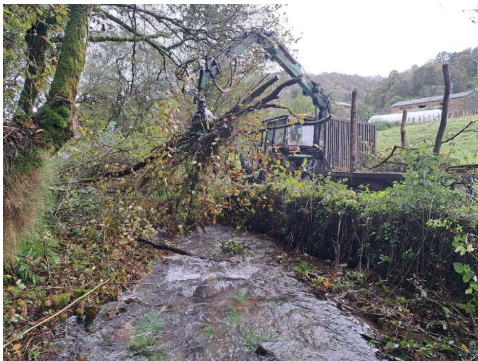
Desarrollo de los trabajos en el río Veiga de Logares
