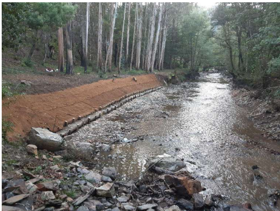
Después de los trabajos
