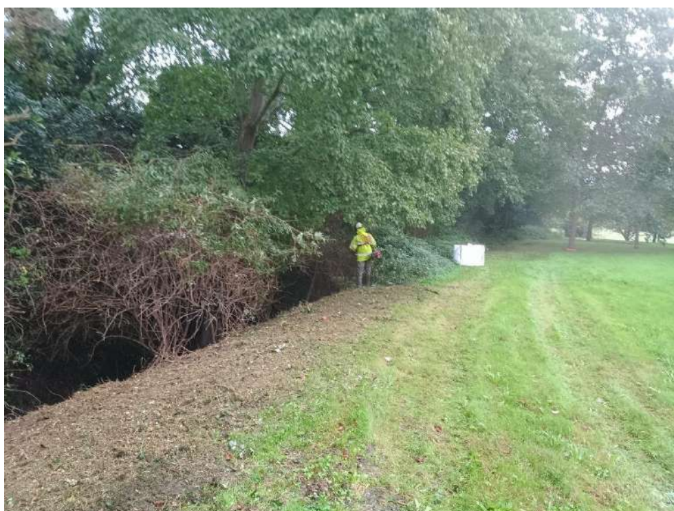
Actuación sobre la vegetación arbustiva
