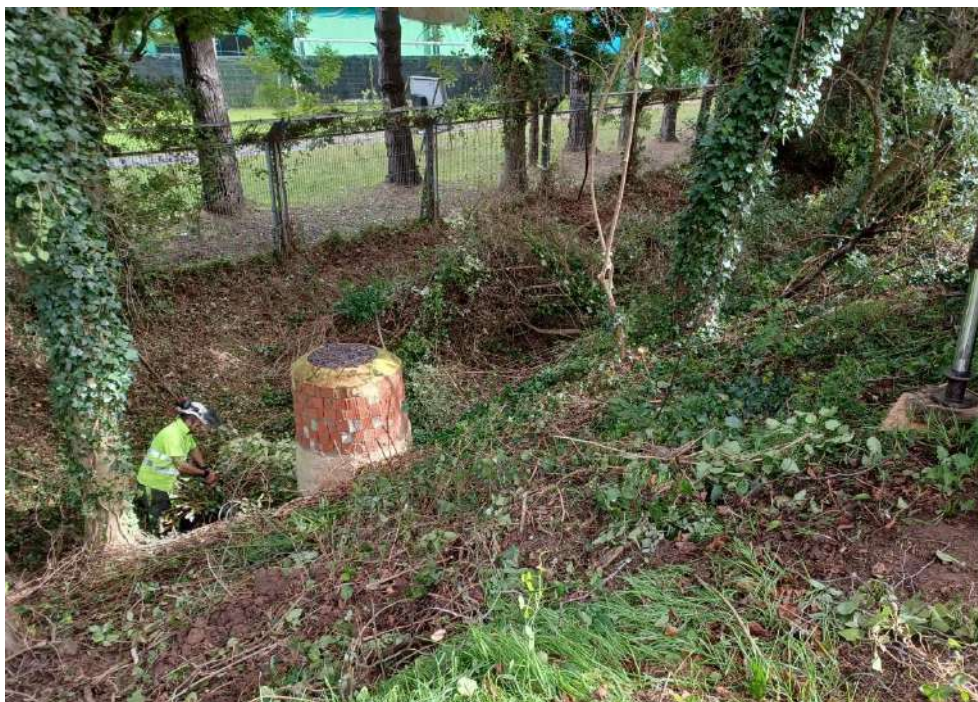
Extracción de restos vegetales del cauce
