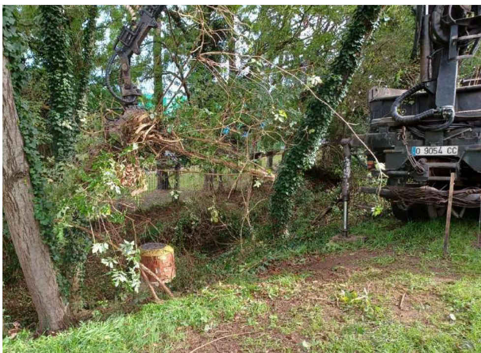
Extracción de restos vegetales del cauce
