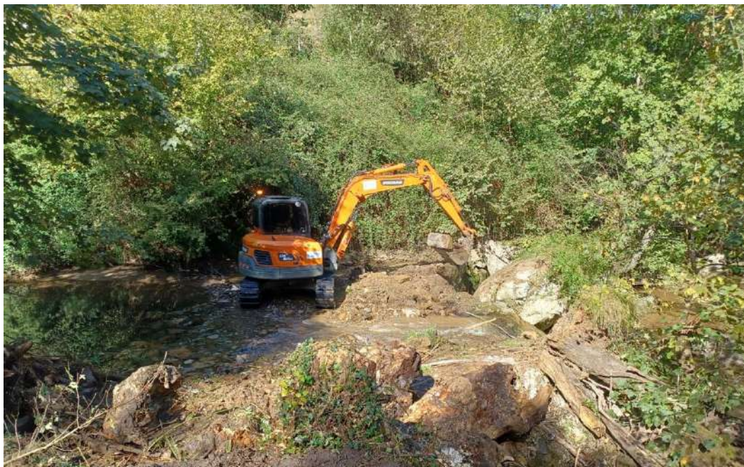
Trabajos de permeabilización de la estructura
