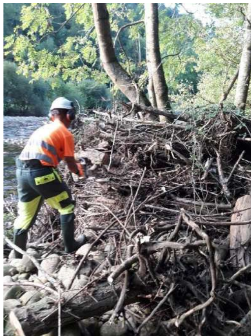
Trabajos de extracción de tapones de restos de vegetales acumulados
