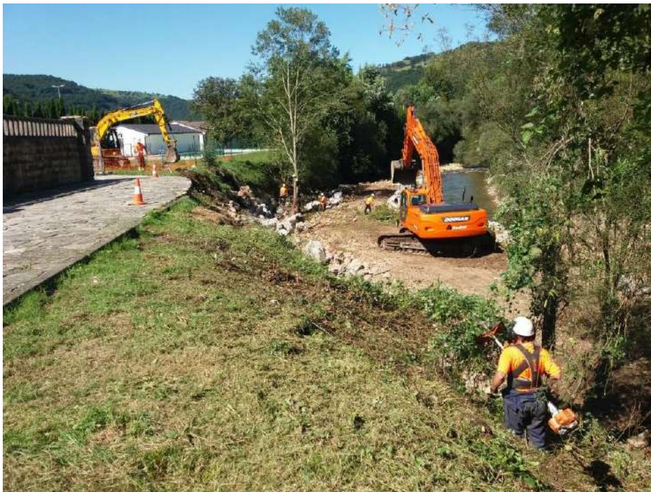
Trabajos previos de desbroce y preparación del terreno
