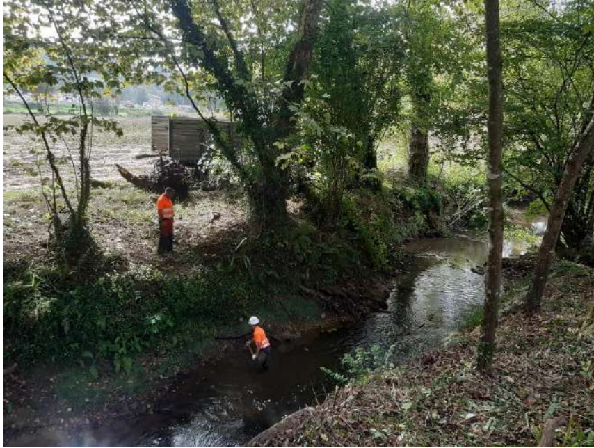
Retirada manual de restos vegetales
