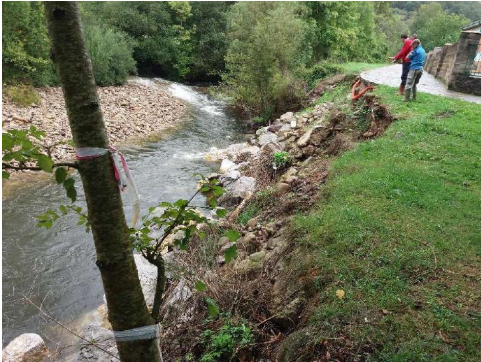
Estado de conservación de la escollera existente
