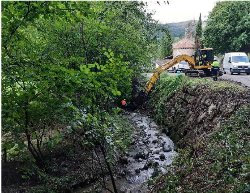
Trabajos de reconstrucción de la escollera dañada
