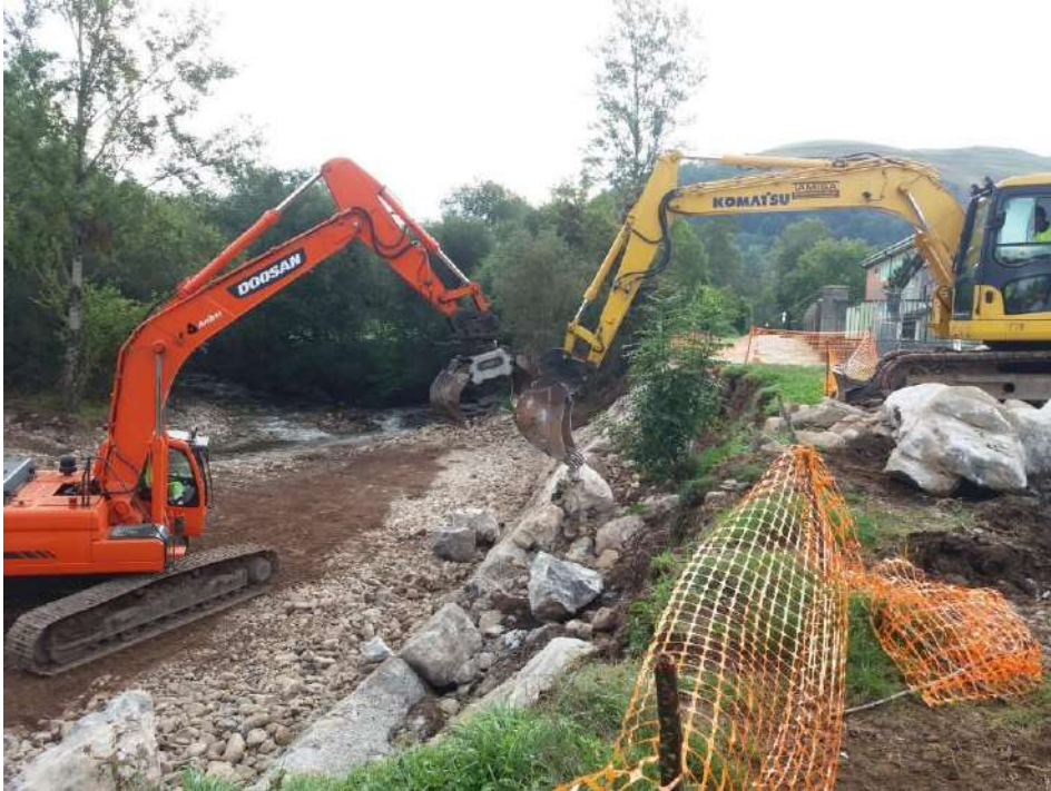
Trabajos de reconstrucción de la escollera
