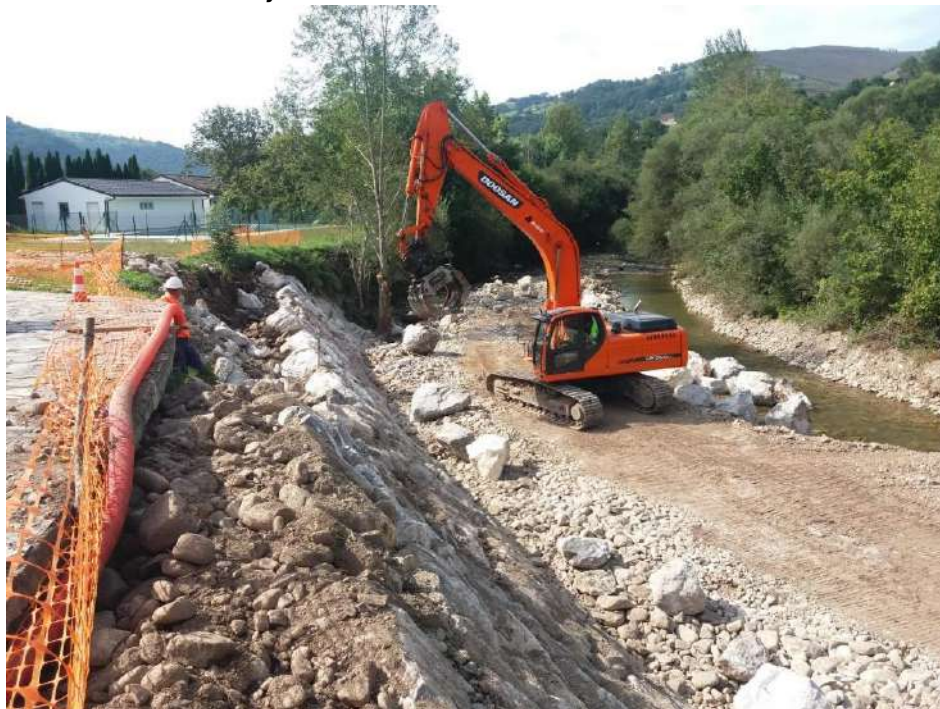
Trabajos de reconstrucción de la escollera
