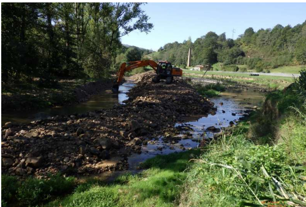
Trabajos de reubicación de acarreos
