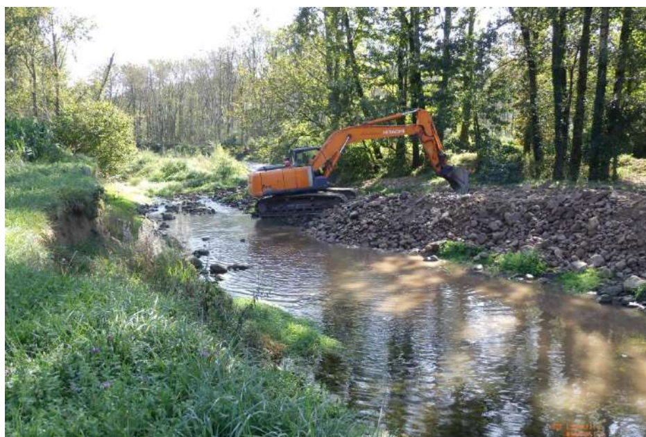
Trabajos de reubicación de acarreos
