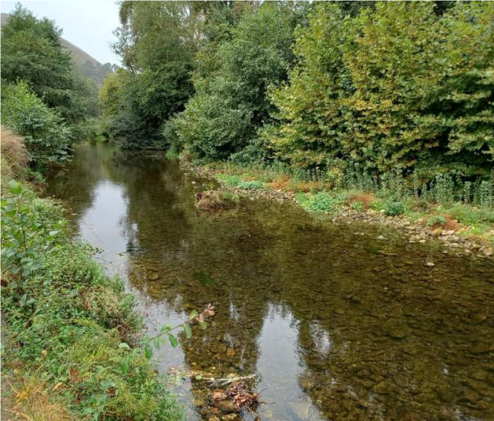
Tramo de actuación después de los trabajos
