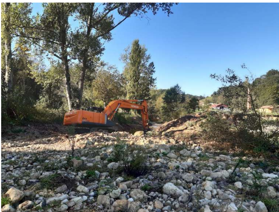
Trabajos de reubicación de acarreos
