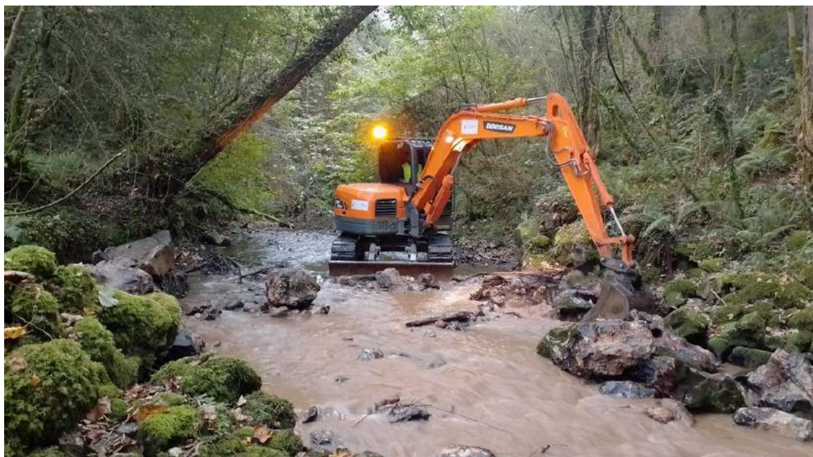
Azud del río Llera durante la demolición
