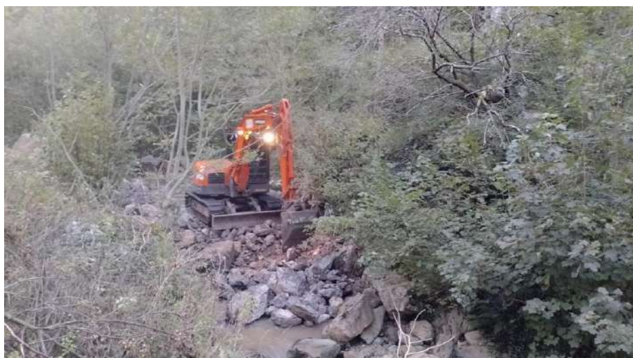
Durante los trabajos en el azud del arroyo de San Julián
