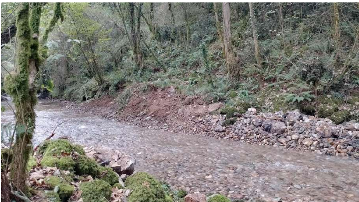
Azud del río Llera después de la demolición
