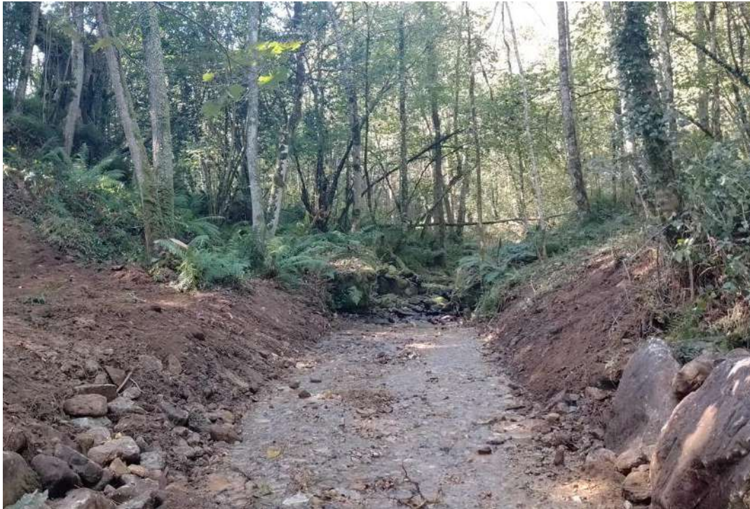
Azud del arroyo Corteguera después de los trabajos
