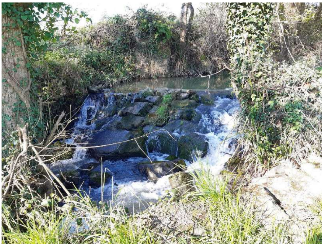
Azud del arroyo Gafares antes de los trabajos
