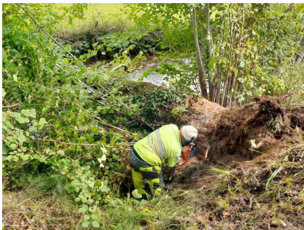
Durante los trabajos de retirada del árbol en Nava
