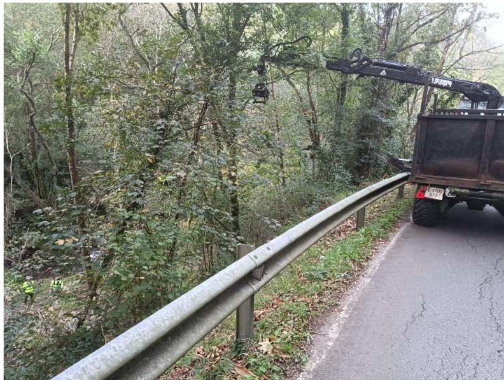
Extracción de restos vegetales el cauce
