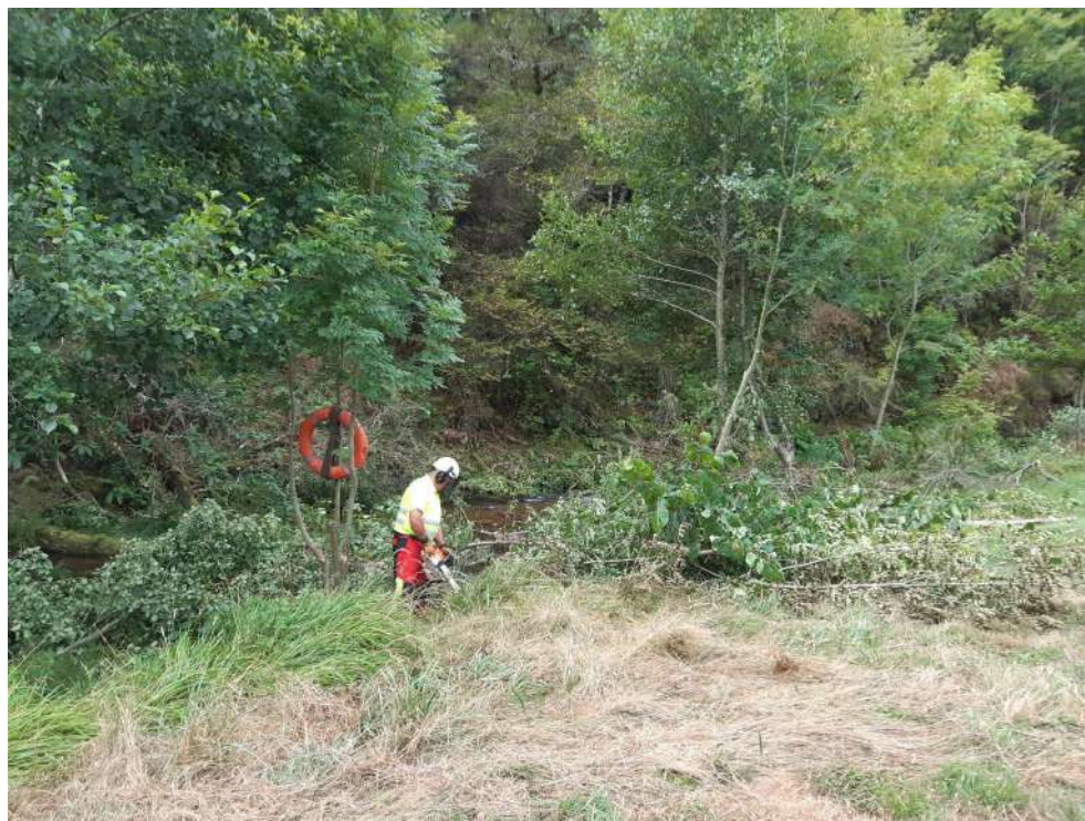
Trabajos sobre la vegetación del cauce
