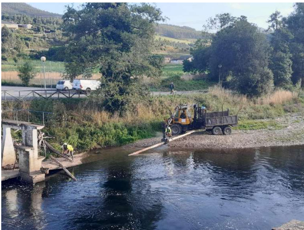
Trabajos de retirada de troncos caídos
