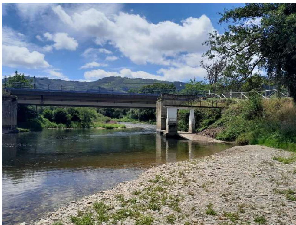
Estado del puente sobre el río Eo tras la intervención
