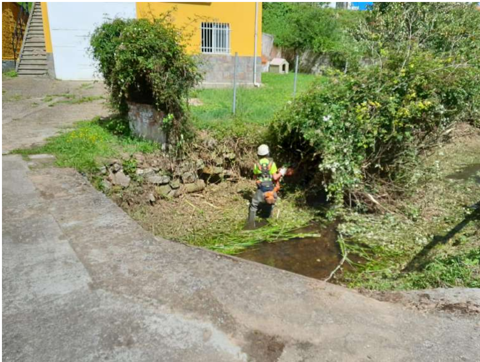
Inicio de los trabajos sobre la vegetación arbustiva del cauce
