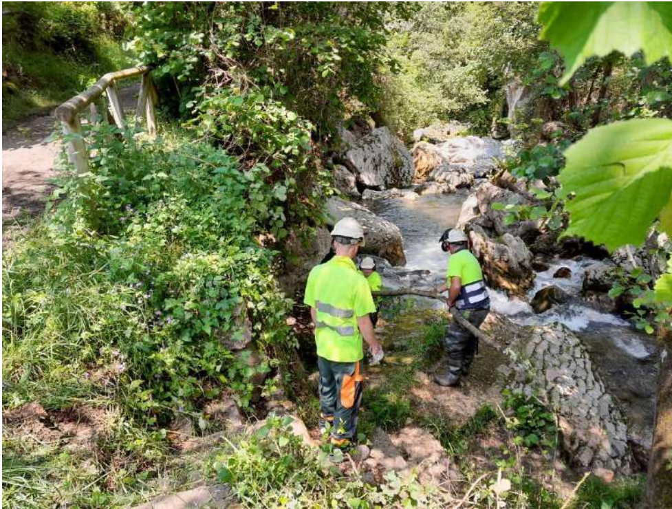
Trabajos manuales de retirada de los restos vegetales
