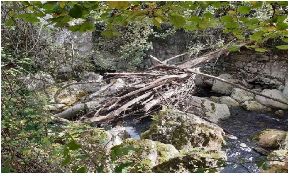
Restos vegetales acumulados en varios puntos del cauce
