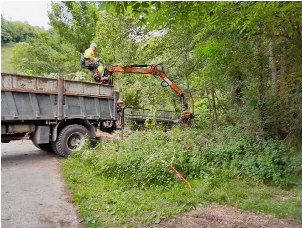
Trabajos mecánicos de retirada de los restos vegetales
