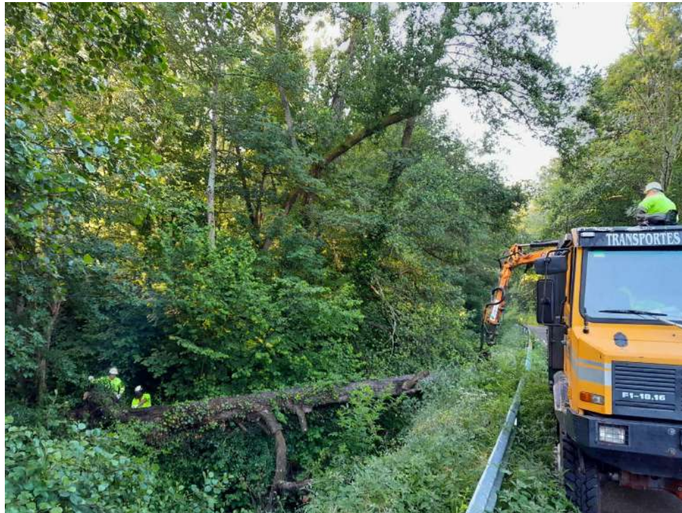
Trabajos de retirada de árboles caídos en el cauce
