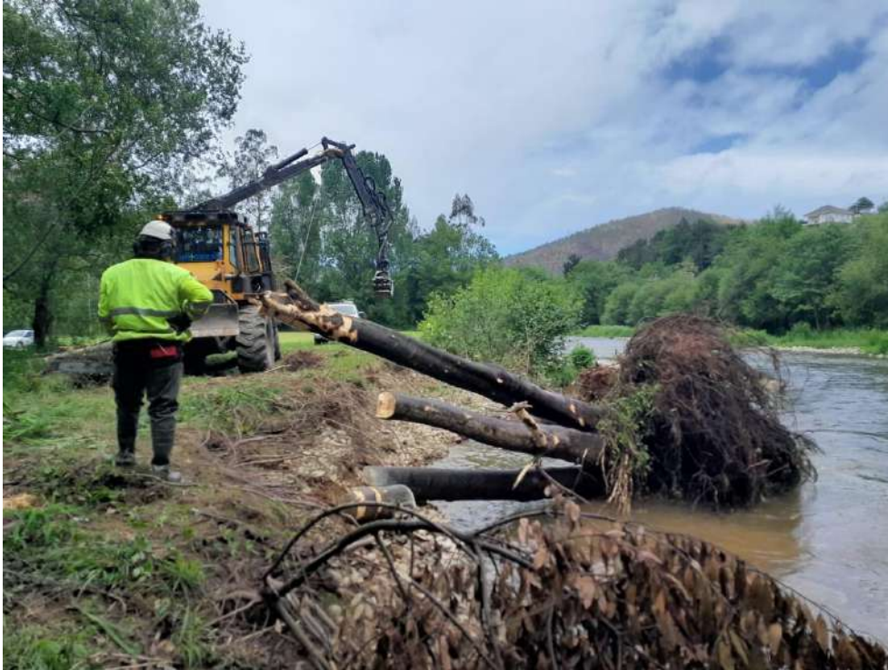
Trabajos de extracción de restos vegetales del cauce
