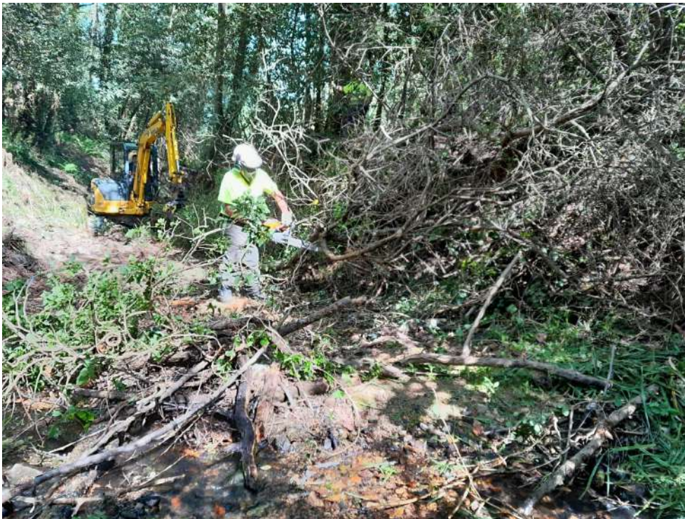
Trabajos de retirada de restos vegetales del cauce
