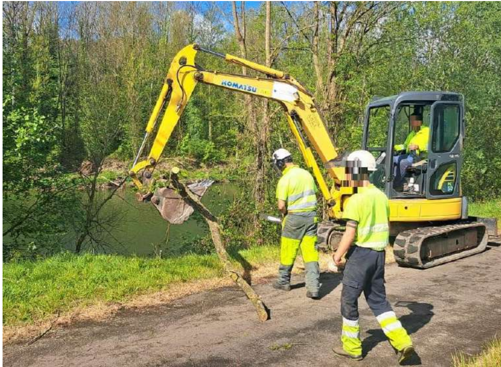
Retirada de restos vegetales acumulados en uno de los puntos erosionados (2/3)
