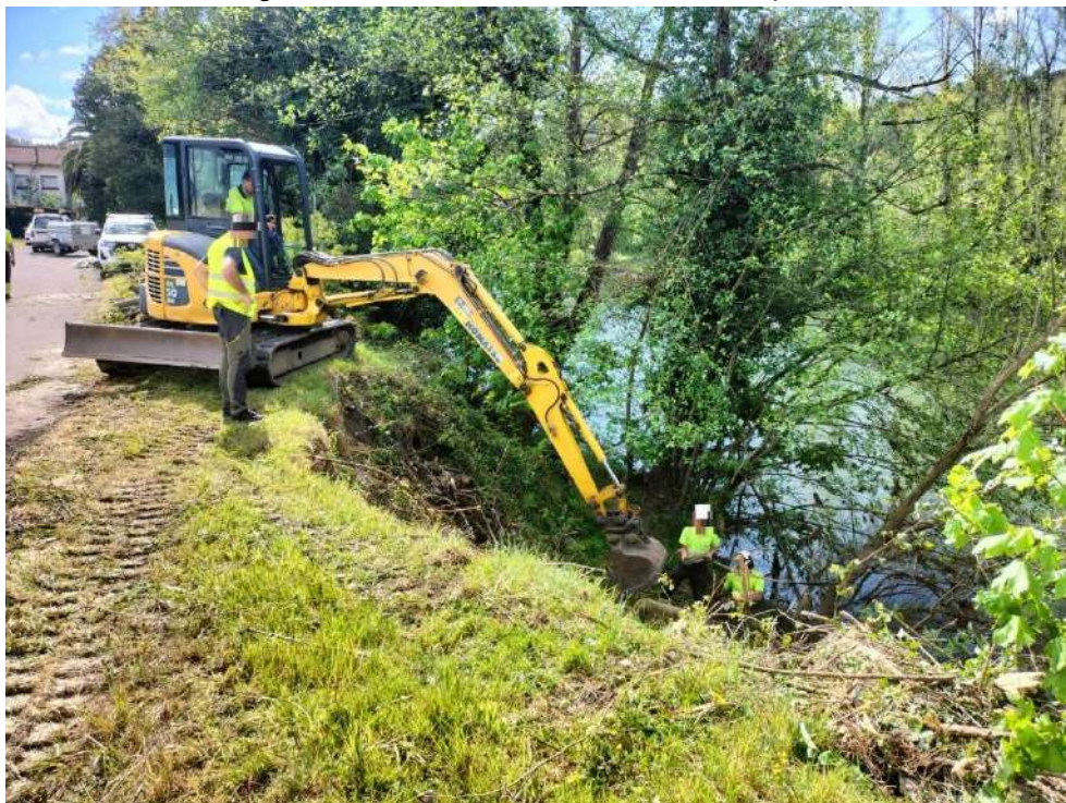
Retirada de restos vegetales acumulados en uno de los puntos erosionados (3/3)
