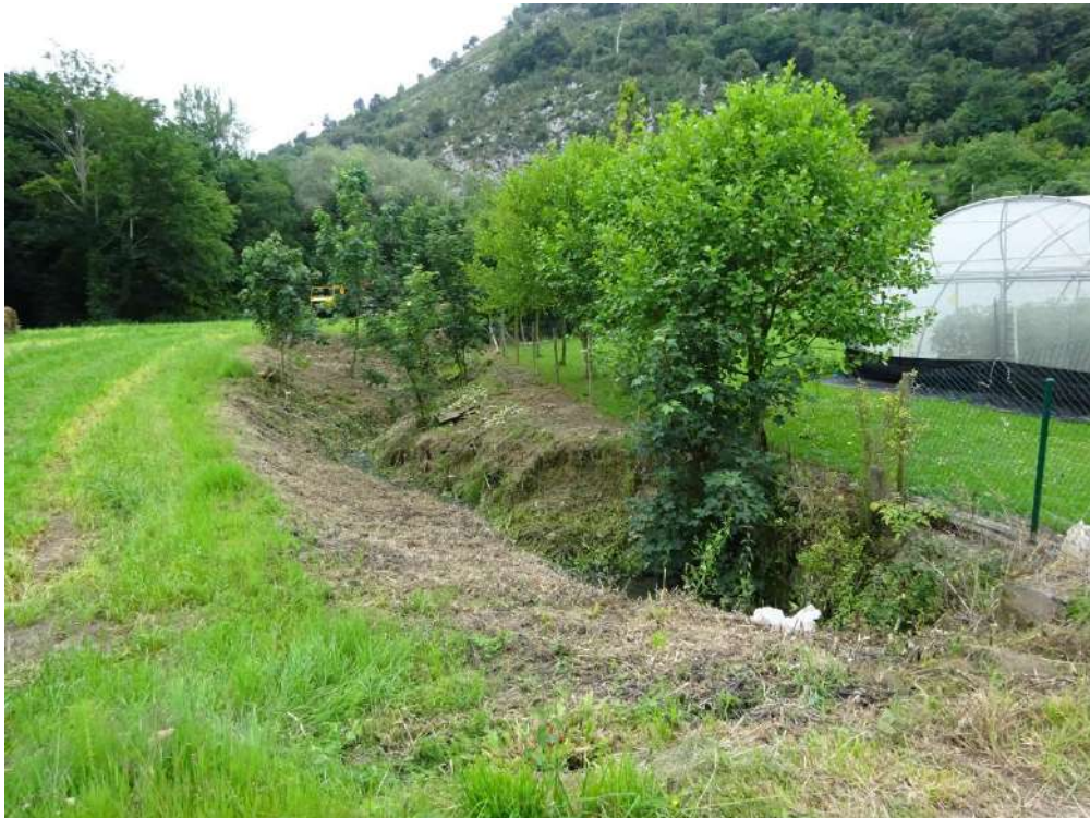
Resultado final tras los trabajos en el arroyo Buelles
