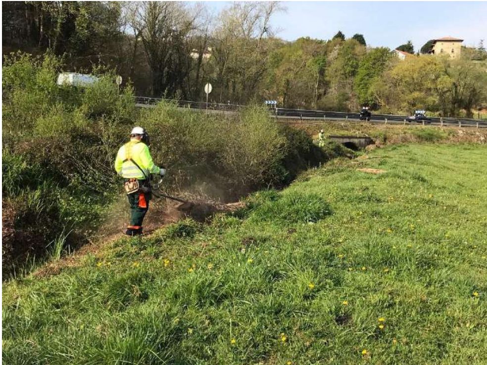
Trabajos de adecuación de la vegetación del cauce
