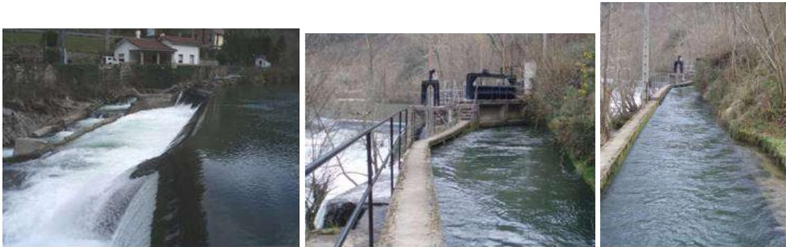
Figura 1 – Detalle del canal, azud, limpiarrejas y toma en CH Caño
