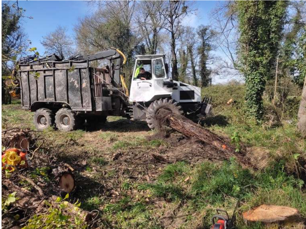
Trabajos de retirada de árboles caídos del río Nora
