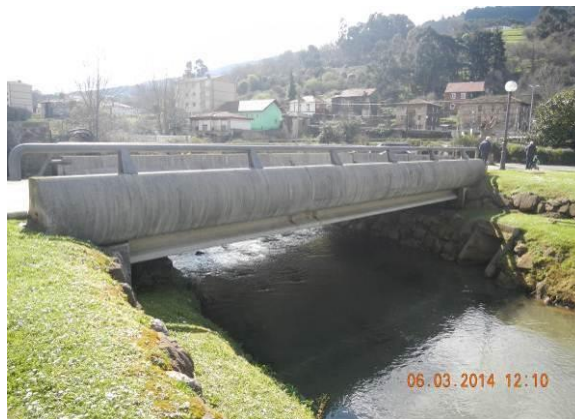
Figura 110.- Pasarela del parque de Arkotxa vista desde aguas abajo
