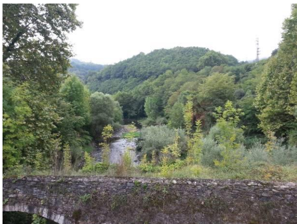
Figura 251.- Vegetación de ribera en buen estado aguas arriba del puente Amillaga. En primer plano el puente viejo de Amillaga en desuso que se prevé demoler.
