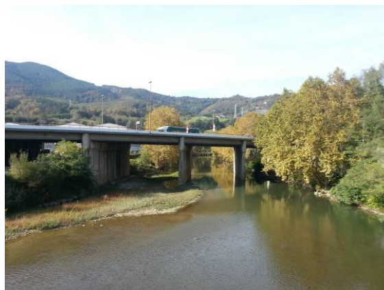
Figura 239.- Aguas abajo del puente del paseo Txintoki. Aguas abajo del Puente de la N-I dominan los grandes plátanos en ambas márgenes.
