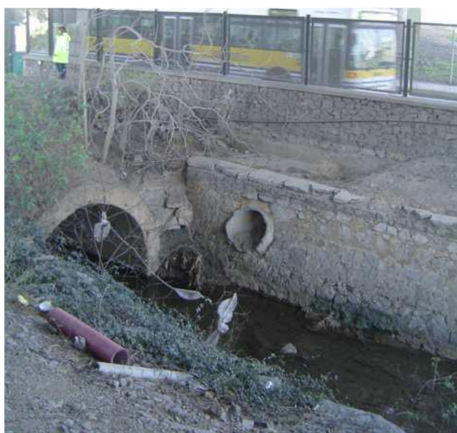
Figura 116.- Cobertura del arroyo Granada a la altura de los pabellones de Bombardier
