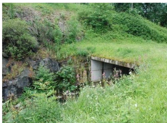
Figura 294.- Salida de una de las coberturas actuales del río Azordoiaga.
