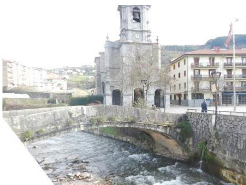
Figura 187.- Pasarela peatonal situada en el río Zelai junto a la Casa de la Cultura.
