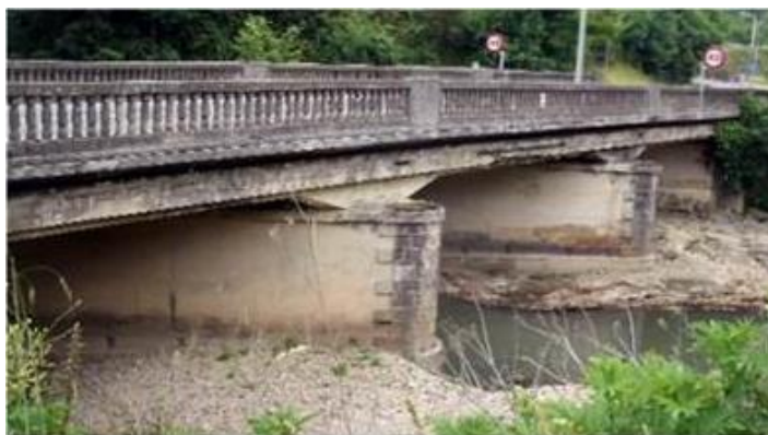
Figura 254.- Puente de la GI-2632 a sustituir
