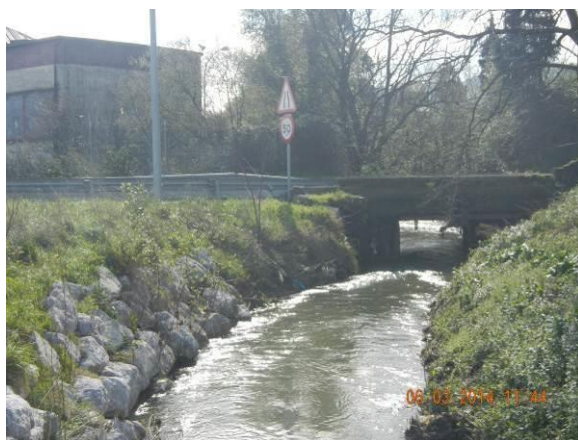
Figura 107.- Puente de la c/Bº de Trápaga a sustituir por la obstrucción que causa
