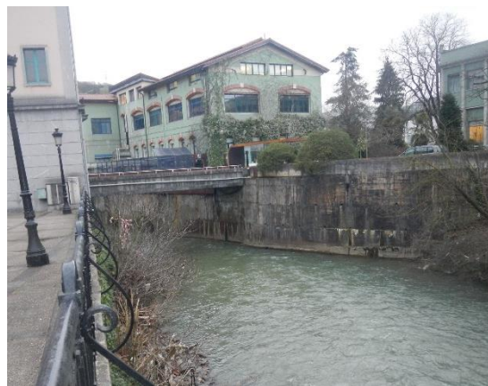
Figura 283.- Paso peatonal y de vehículos a reponer
