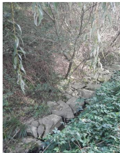
Figura 19.- Aspecto tras la obra
