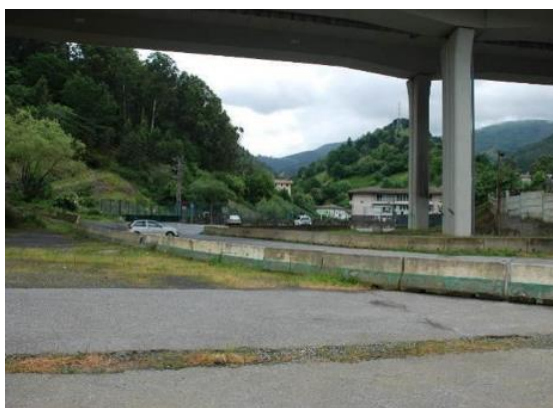
Figura 293.- Tramo soterrado del río Azordoiaga.
