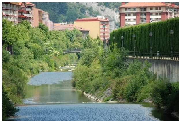
Figura 203.- Nerbioi a su paso por el ámbito de la fase 2. Se observa la banqueta de aguas bajas y la escollera y muro de contención junto al paseo de la margen derecha.
