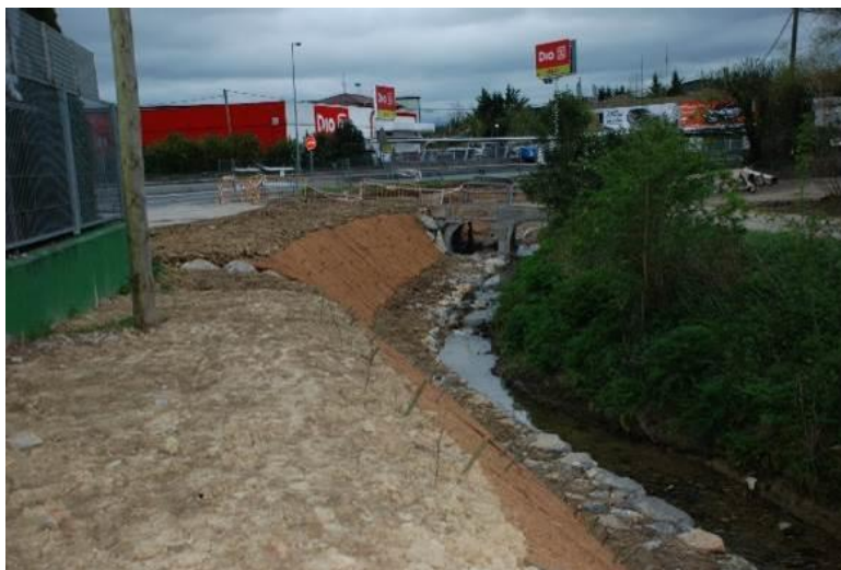
Figura 18.- Ampliación por la margen derecha
