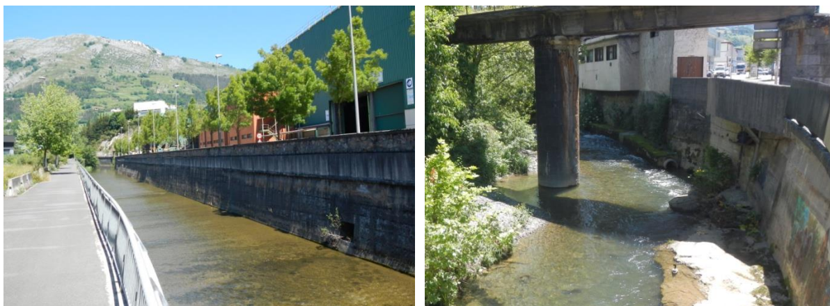
Figura 53.- Izquierda: Tramo encauzado a naturalizar. Derecha: Estado del río Ibaieder aguas abajo del tramo encauzado donde la fijación del lecho está rota.
