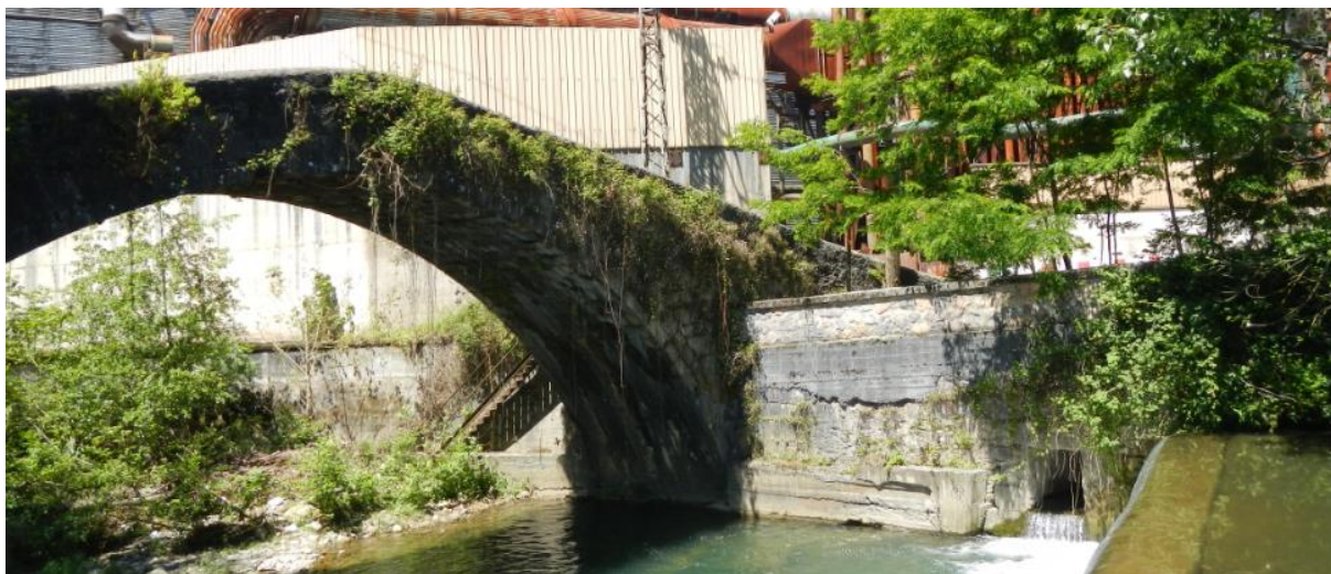
Figura 51.- Puente de Amube. Elemento patrimonial calificado.
