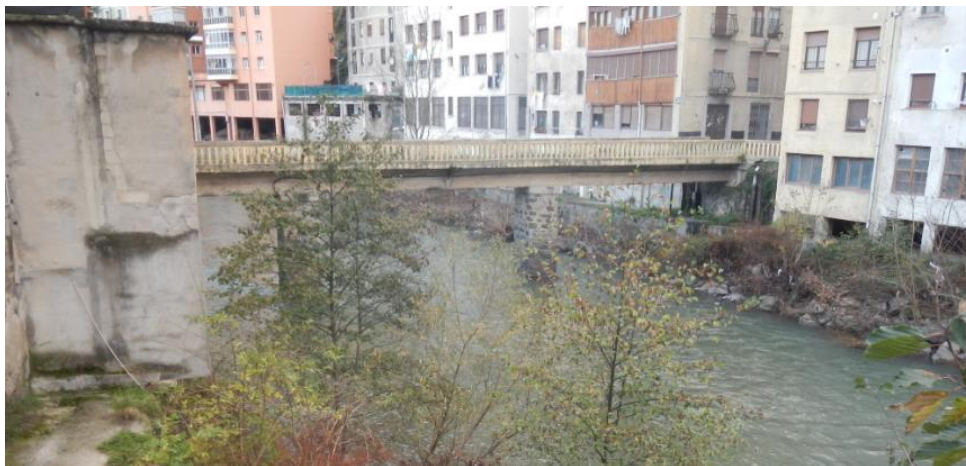
Figura 271.- Pasarela a sustituir. PK 2+060.
