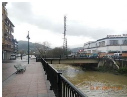
Figura 62.- Puente de Rentería
