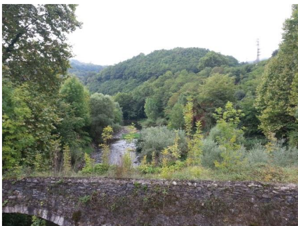
Figura 256.- Vegetación de ribera en buen estado aguas arriba del puente Amillaga. En primer plano el puente viejo de Amillaga en desuso que se prevé demoler.
