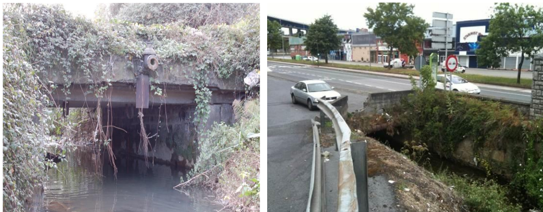
Figura 115.- Arroyo Granada a la altura de Desguaces Correa
