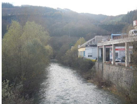
Figura 257.- Tramo entre el puente de Matxiategi y campo de fútbol. Márgenes modificadas con escasa vegetación, especialmente en margen derecha.
