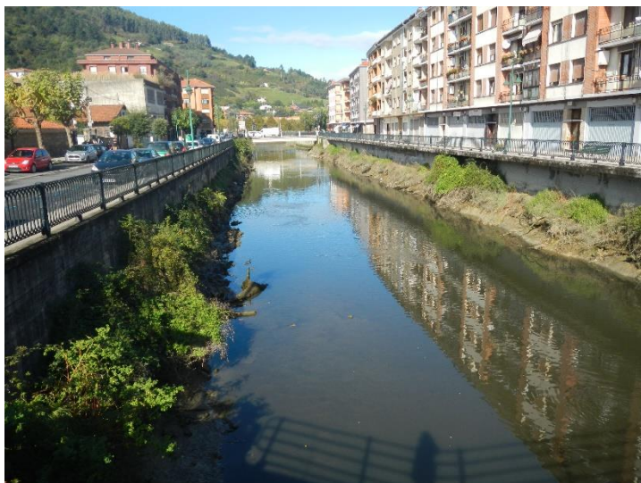
Figura 72.- Tramo del río Oka encauzado a su paso por la zona urbana de Gernika
