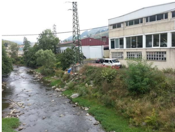
Figura 250.- Tramos sin vegetación en margen derecha aguas abajo del puente Amillaga
