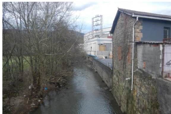
Figura 154.- Pabellones aguas abajo de la BI-3333
