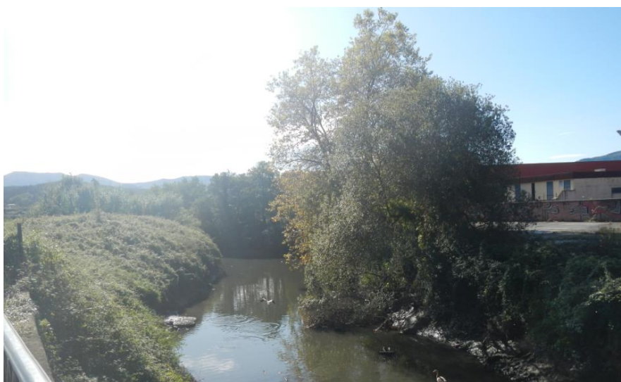
Figura 74.- Ejemplar aislado de aliso en margen izquierda junto a los pabellones industriales y margen derecha desprovista de vegetación propia de ribera con proliferación de bardas.
