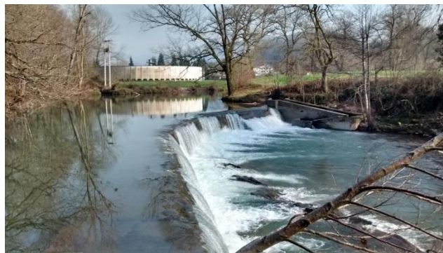
Figura 305.- EDAR de Baztán desde el azud de aguas abajo
