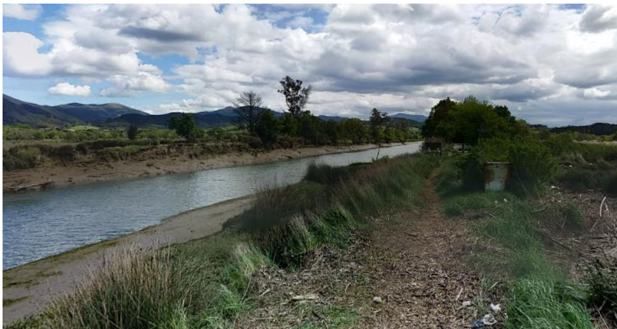
Figura 75.- Canal del Corte de la Ría limitado entre motas a ambos lados.
