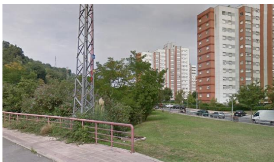
Figura 100.- Zona a disponer mota aguas abajo del puente de la calle Ametzaga
