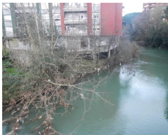
Figura 164.- Presión urbana en margen derecha aguas arriba del puente de la calle Fray Juan de Zumarraga
