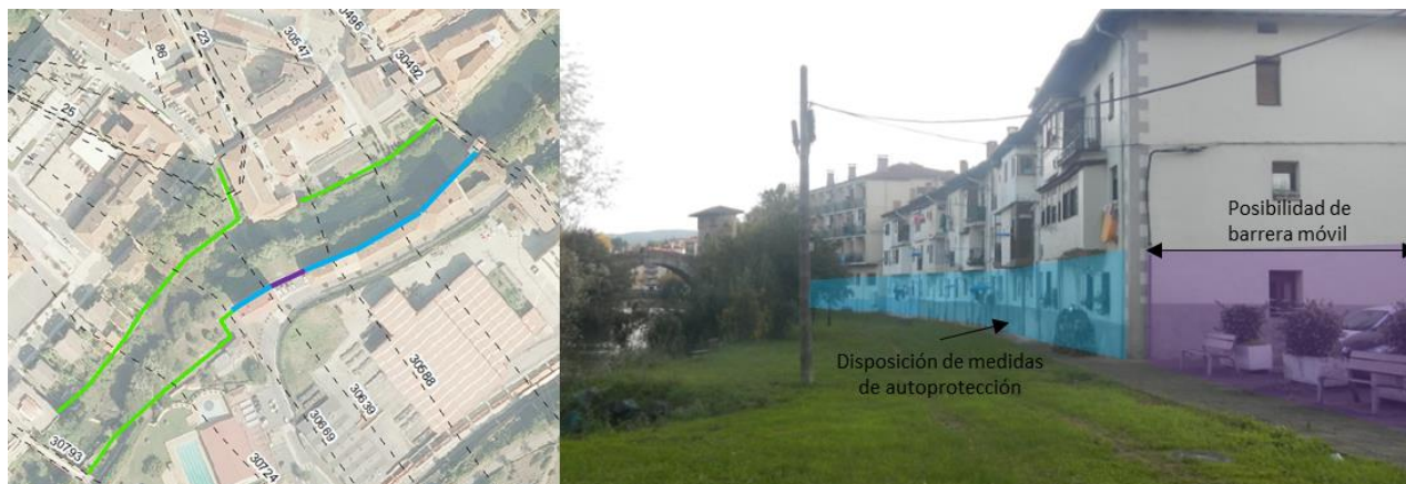
Figura 224.- Vista desde aguas arriba del puente Viejo en Balmaseda; viviendas en margen derecha
