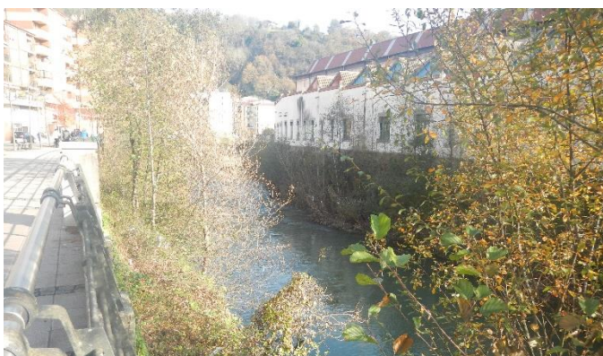
Figura 279.- Tramo del río Oria encauzado, con ejemplares de aliso en la margen izquierda
