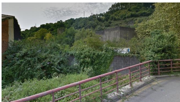
Figura 101.- Pabellón y muro existente aguas arriba del puente de la calle Ametzaga
