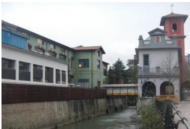
Figura 282.- Edificios y pasarela peatonal a demoler.
