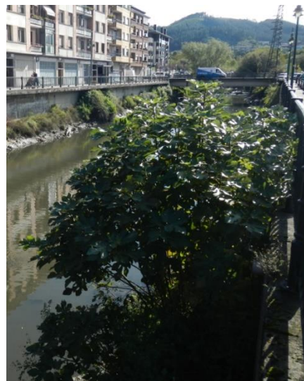
Figura 73.- Higuera implantada en el muro lateral del tramo encauzado
