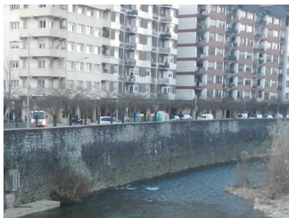
Figura 183.- Muro con tubos de drenaje en los que anida el avión zapador en el río Oria, PK 34+289
