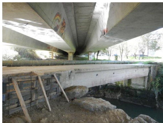
Figura 79.- Zona de cierre del muro en MI bajo el paso de la BI-635
