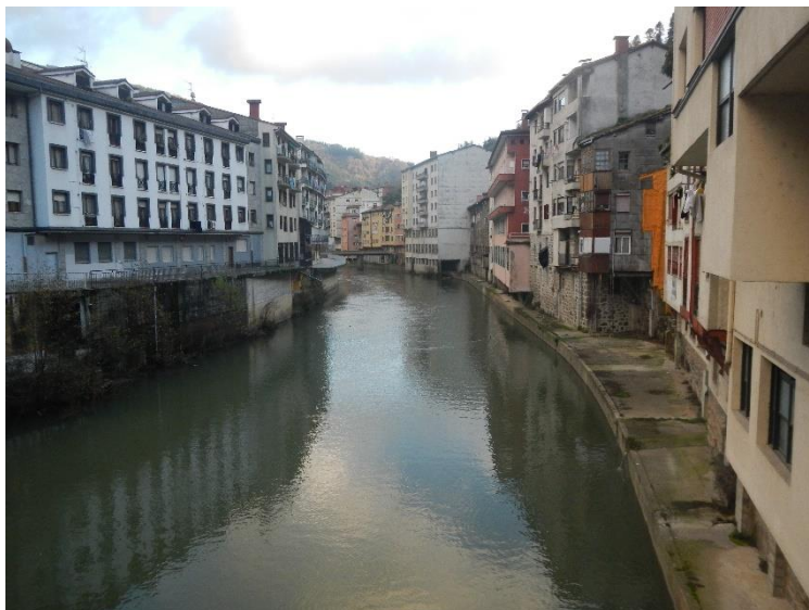
Figura 273.- Núcleo urbano de Soraluze, edificaciones que flanquean el cauce.
