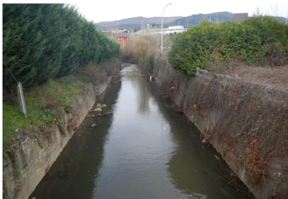
Figura 145.- Encauzamiento del río Zaldu
