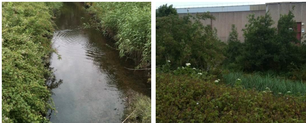
Figura 114.- Río Galindo a la altura del polígono industrial Aparcabisa. En tramos el río está completamente cubierto por zarzas
