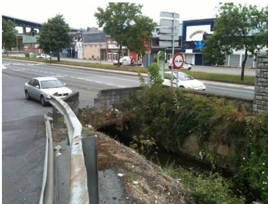
Figura 91.- Cobertura río Granada en Trápaga
