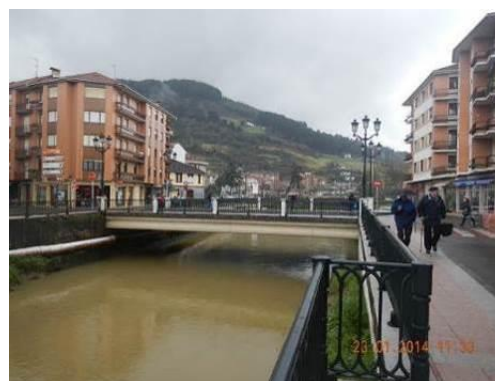
Figura 61.- Encauzamiento actual y puente de San Bartolomé
