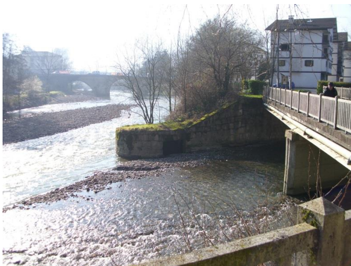
Figura 298.- Puentes sobre el río Ezcurra y Bidasoa en la confluencia de ambos
