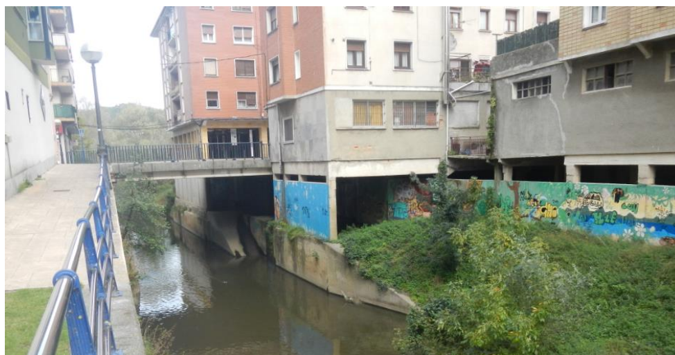
Figura 28.- Tramo urbano en el que el río está limitado por un muro lateral de hormigón en margen izquierda y los paramentos de los edificios en margen derecha, estando dos edificios situados sobre el cauce.
