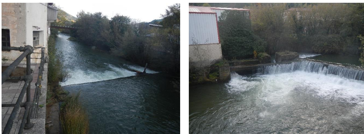
Figura 225.- Azudes sucesivos de la ferrería de Laiseca. El azud de aguas abajo del PK 31+254 (izda.) se elimina, el azud de aguas arriba, se rebaja 1 m para mantener la derivación lateral donde se conserva la toma y vertido
