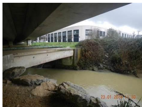
Figura 63.- Zona de cierre del muro en la zona de paso de la BI-635
