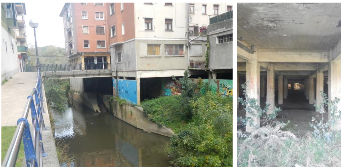
Figura 30.- Edificios a demoler aguas a la altura de la calle Lauaxeta Olerkari y bajos de dichos edificios
