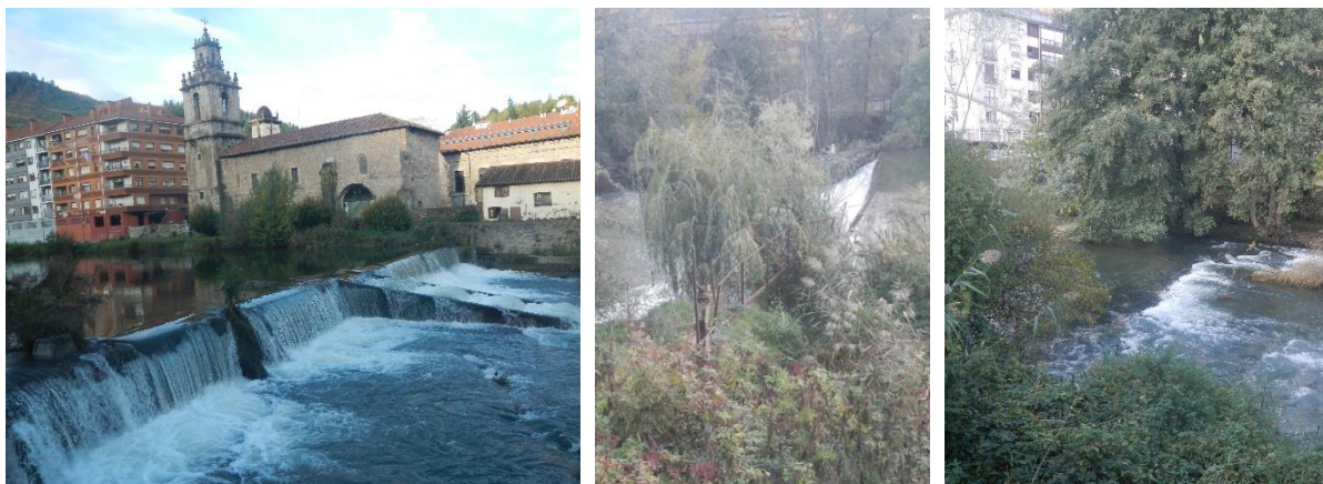
Figura 219.- Algunos de los azudes existentes en el tramo
