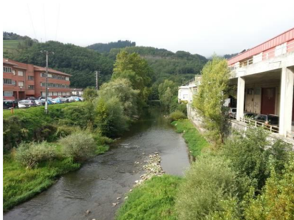
Figura 252.- Tramo entre el puente de Matxiategi y campo de fútbol. Márgenes modificadas con escasa vegetación, especialmente en margen derecha.
