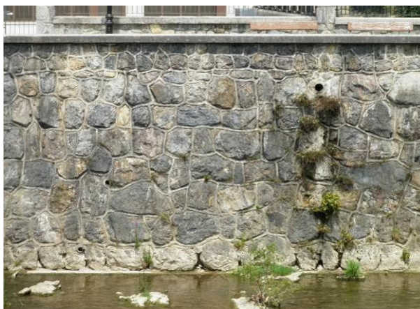
Figura 49.- Vista de los tubos de drenaje, zona potencial para la nidificación del avión zapador.
