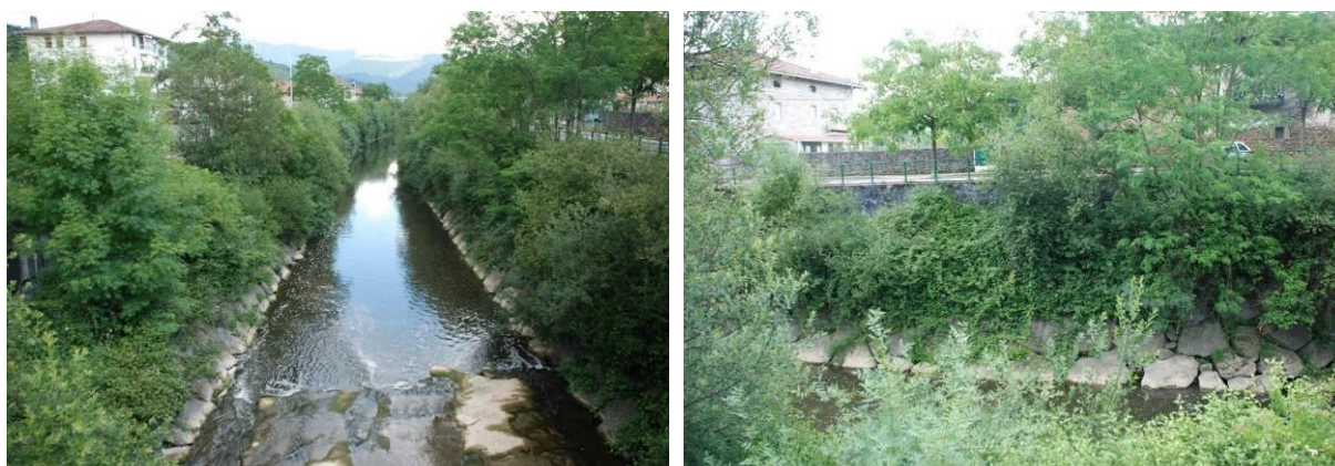
Figura 204.- Nerbioi a su paso por barrio de Santa Cruz. Tramo modificado con taludes de escollera.
