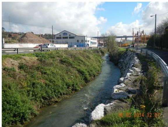
Figura 108.- Zona de cauce a acondicionar
